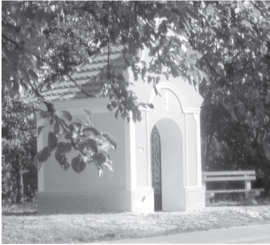
Stritschitz Die Bonaschn Kapelle nach der Renovierung
