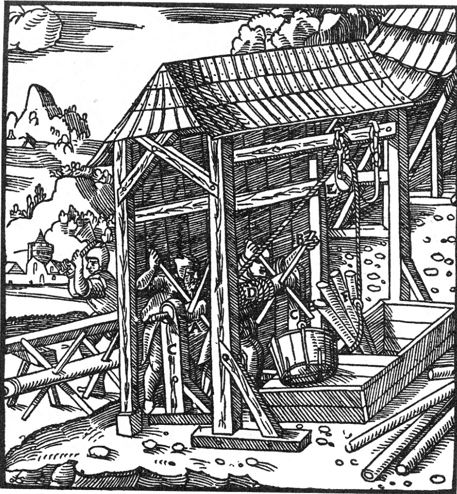
Вал А. Хрестовина В. Стояки С. Канат D. Блок Е. Колоди, які спускають, F.
