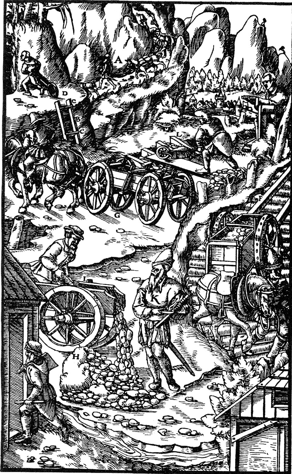
В'ючні коні А. Похилий довгий жолоб приставлений до скелі, В. Дошки жолоба С. Одноколісна тачка D. Двоколісна тачка E. Колоди F. Віз G. Розвантаження руди з воза H. Засув I. Штейгер, який відмічає на бірці число возів, K. Ящики, в які завантажують руду для переділу, L.
