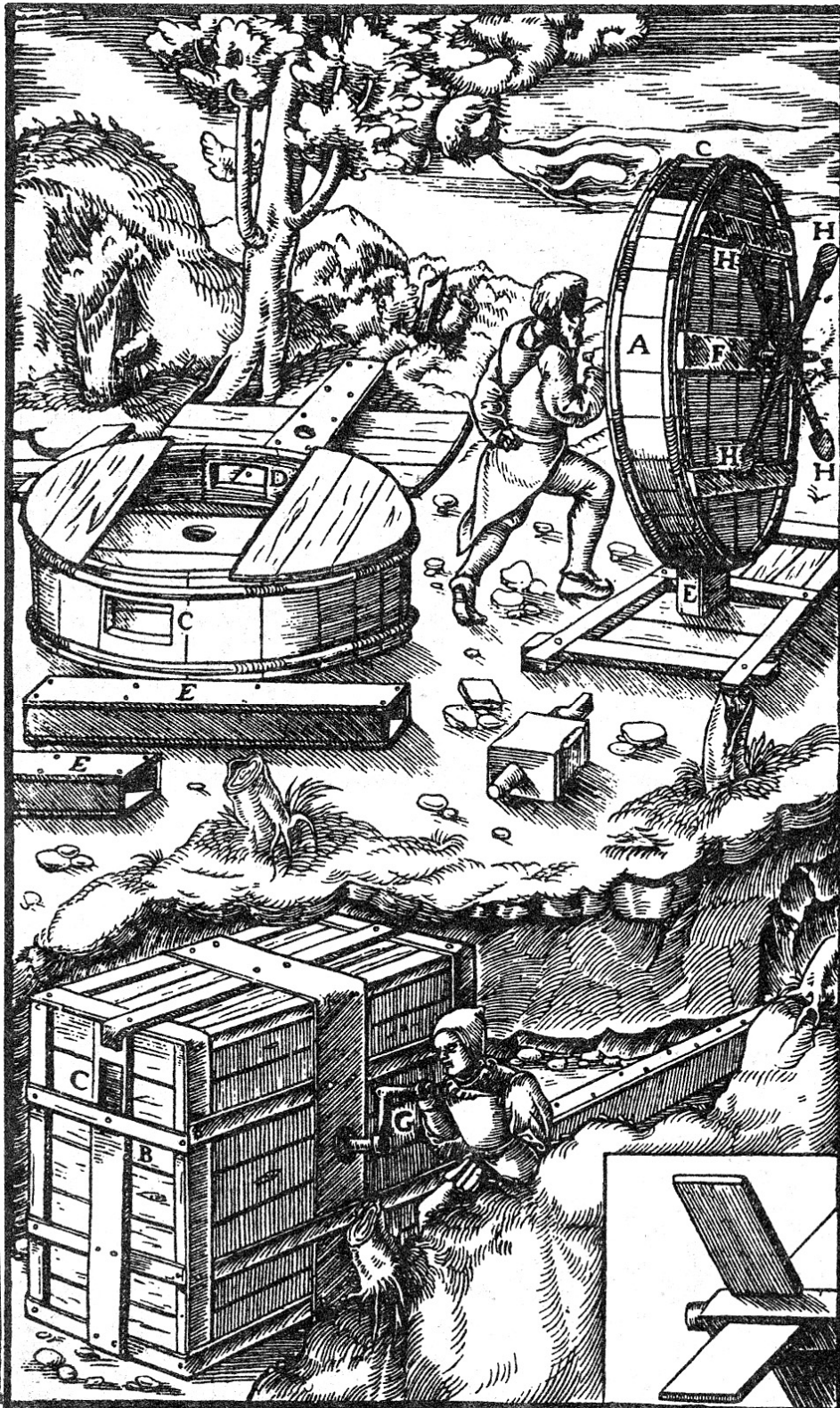
Барабан А. Прямокутний короб (футляр) В. Повітряний отвір С. Другий отвір D. Трубопровід (канал) Е. Вал F. рукоятка G. Штанги (хрестовина) H.
