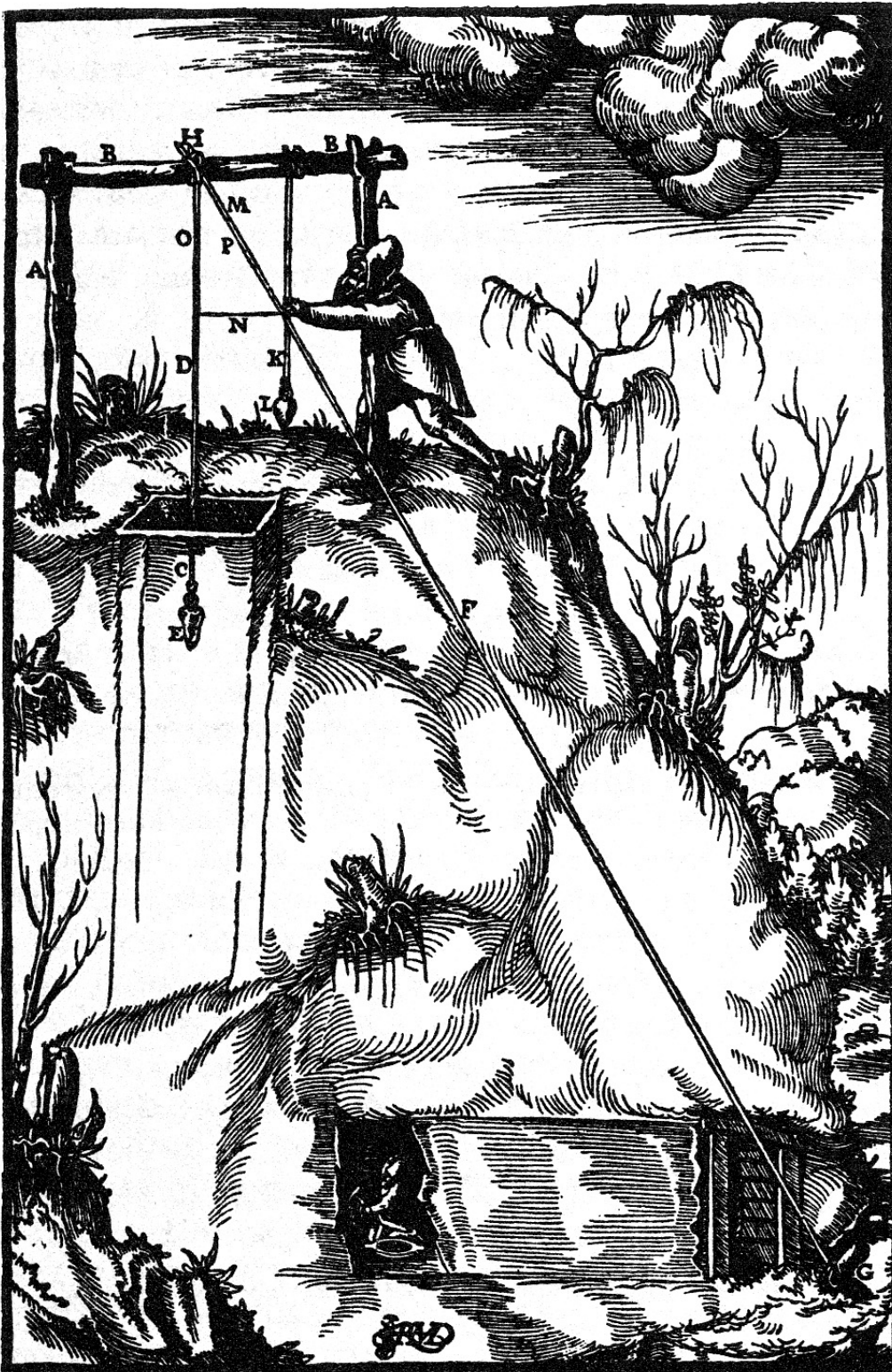
Стояки А. Поперечина В. Шахтний стовбур С. Перший шнур D. Вантаж на першому шнурі Е. Другий шнур F. Кріплення того ж шнура на землі G. Початок першого шнура H. Устя штольні J. Третій шнур K. Вантаж на третьому шнурі L. Перший розмір (вимірювання) M. Другий розмір (вимірювання) N. Третій розмір (вимірювання) O. Трикутник P.
