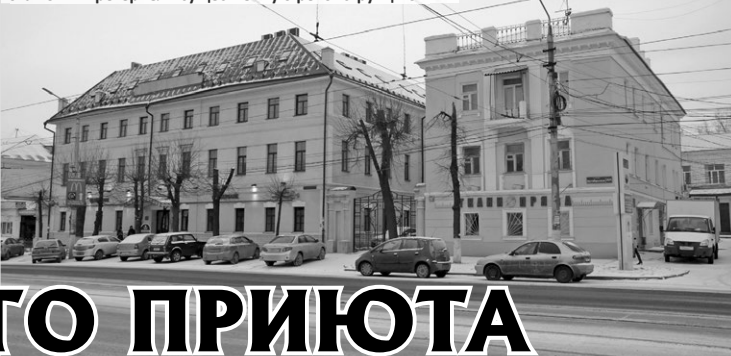
Дома № 20 и №20-а на улице Октябрьской, в которых находился Михайловский детский приют. В советское и постсоветское время оба они были надстроены третьим этажом и претерпели существенную реконструкцию.
