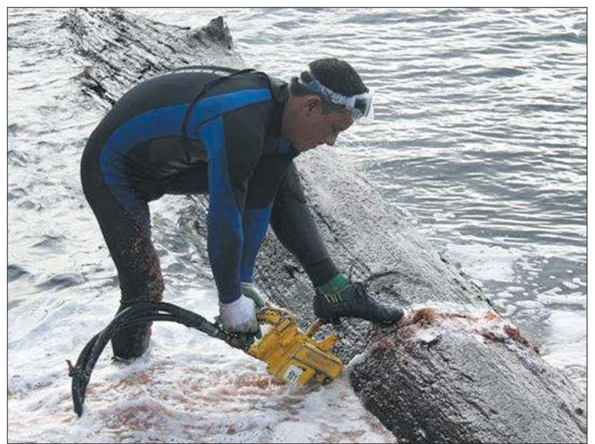
Der Taucher arbeitet im Wasser nur mit einer hydraulischen Kettensäge, die auch die Arbeitstiefe bis zu 35 m problemlos mitmacht
