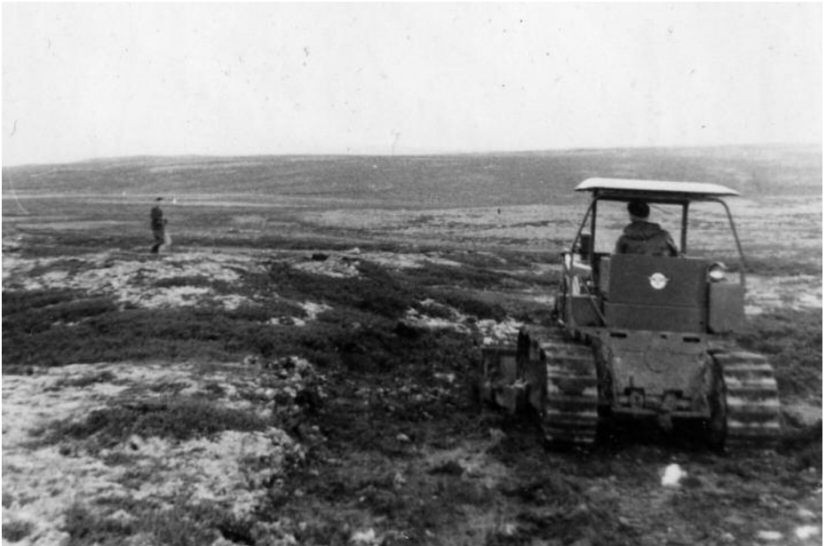
Frå byggjinga av Slådalsvegen hausten 1959. Fotoutlån: Erik Holo.
