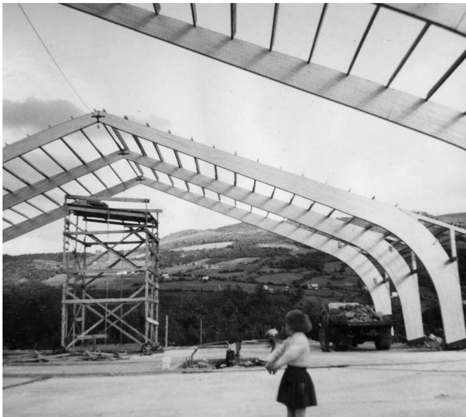
Bygging av OKB-garasja ca 1961. Dei tok tidleg i bruk limtre. Foto frå Erik Holø.
