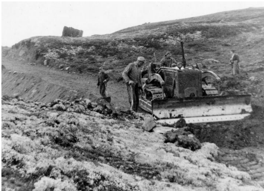
Berg-karane, byggjing av Slådalsvegen hausten 1959. Foto frå Erik Holø.
