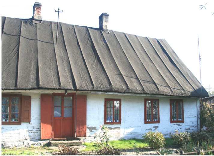
Fragment budynku starej karczmy w Rokicinach-Kolonii (fot. 2008).
