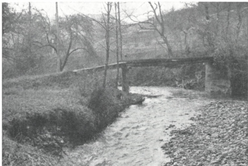
Sl. 25. Ena izmed zelo značilnih oblik preprostega (vaškega) mostu prek poplavnega ali hudourniškega potoka
