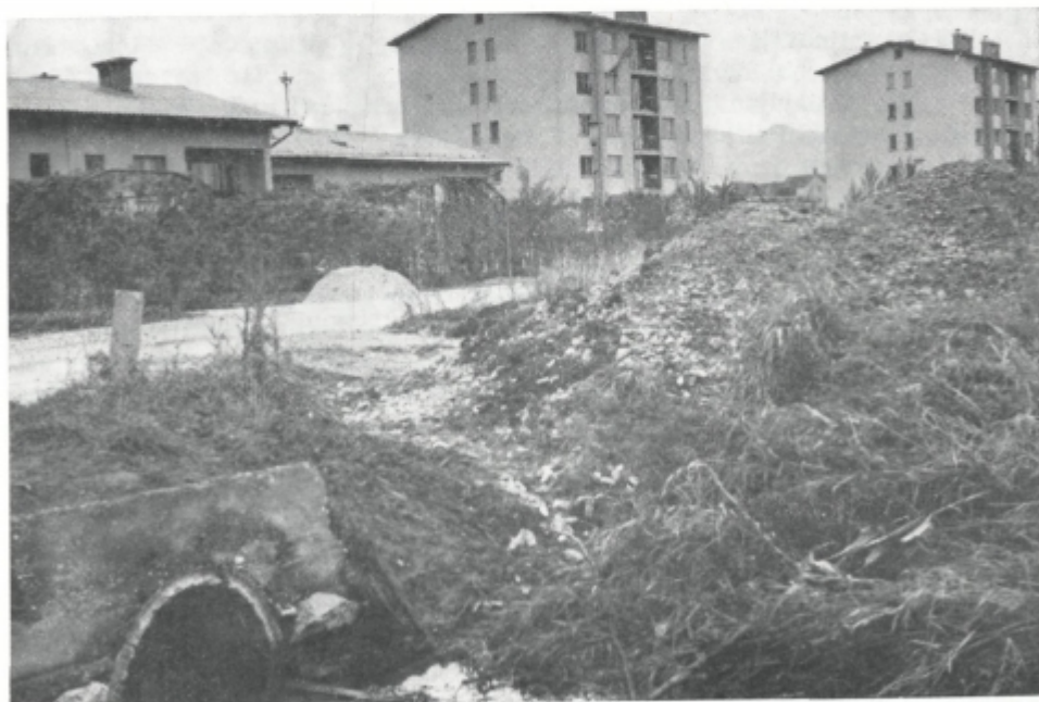
Sl. 27. Narasli Godomlji, ki izvira med Gotovljami in Žalcem, ni zadostovala tale velikost prepustne cevi pod ložniško cesto. Voda se je razlila po soseski Ložnice (severni del mesta Žalec) tudi leta 1973 in 1974
