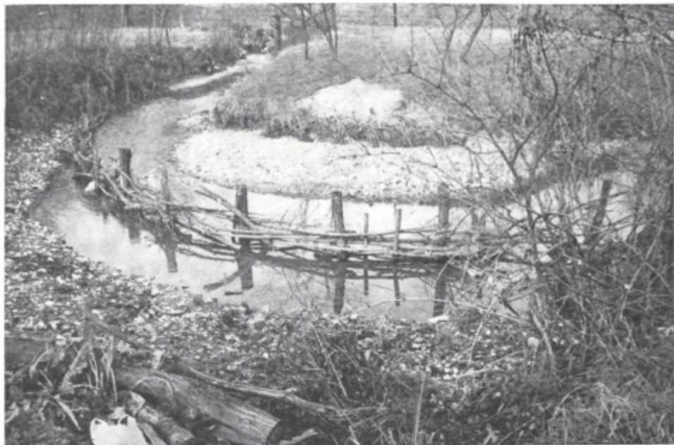
Sl. 14. Človek z najrazličnejšimi napravami v rečnih koritih preprečuje bočno erozijo. Eno izmed številnih zavarovanj korita Pirešice v naselju Velika Pirešica
