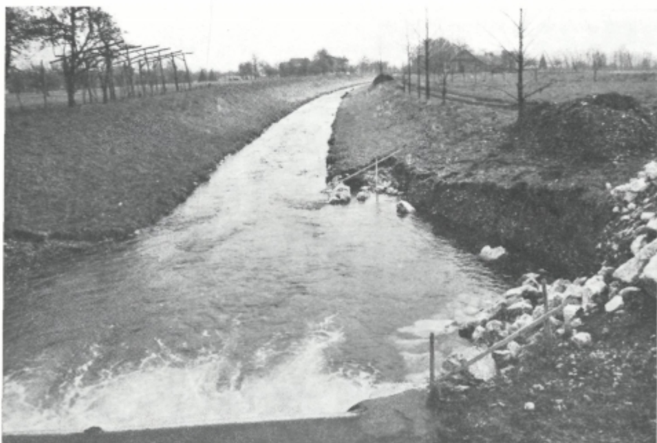
Sl. 6. Visoke vode neposredno pod pragovi razdirajo brežine. To je ena izmed številnih poškodb, ki so jih povzročile jesenske povodnji 1973 in 1974 na reguliranem delu Trnavce med Glinjami in Šentrupertom
