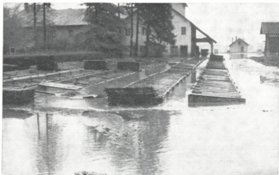
Sl. 28. Med Ložnico in Savinjo je Spodnji Medlog, kamor sega zahodni del celjskega predmestja. Kljub temu, da sta Savinja in Ložnica že dlje časa regulirani, so zalile visoke povodnji že večkrat ta del Celja. Pogled na poplavljeni zaprte grede celjskega vrtnarstva, kakršne so bile 25. X. 1965. leta (foto L. Dermol)
