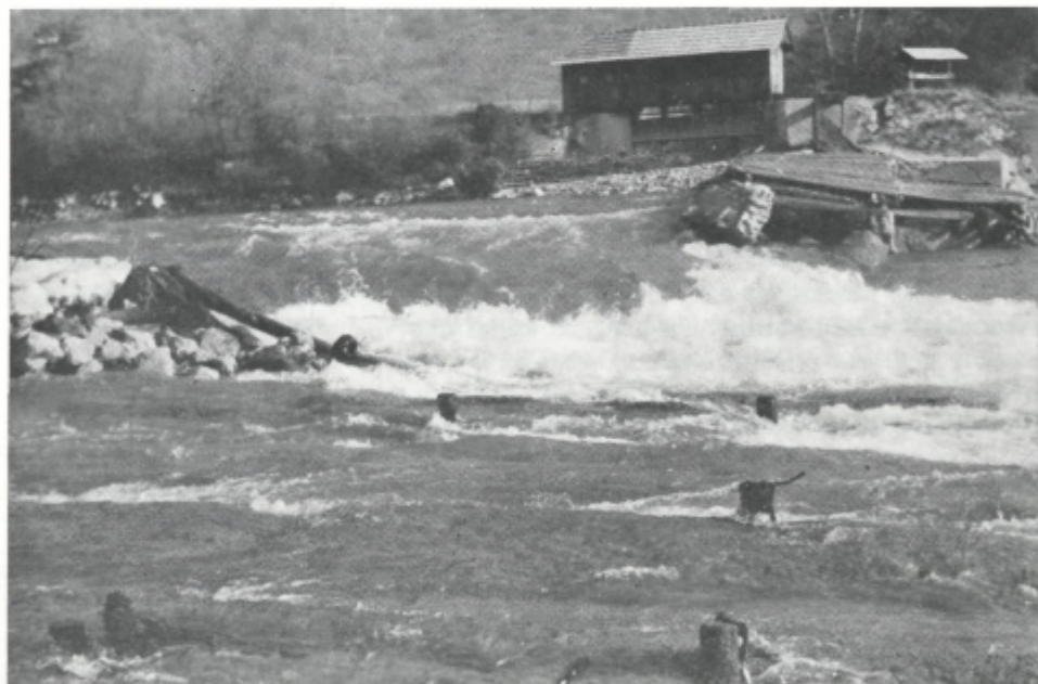
Sl. 8. Podvinski jez med Zgornjim Podvinom in Malimi Braslovčami je največji vodno-gradbeni objekt na Savinji v Spodnji Savinjski dolini. Napaja (Podvinsko) Strugo, ki je še danes pomembna pogonska moč številnih obratov. Jesenska povodenj 1973 je uničila jez, a so ga kmalu obnovili
