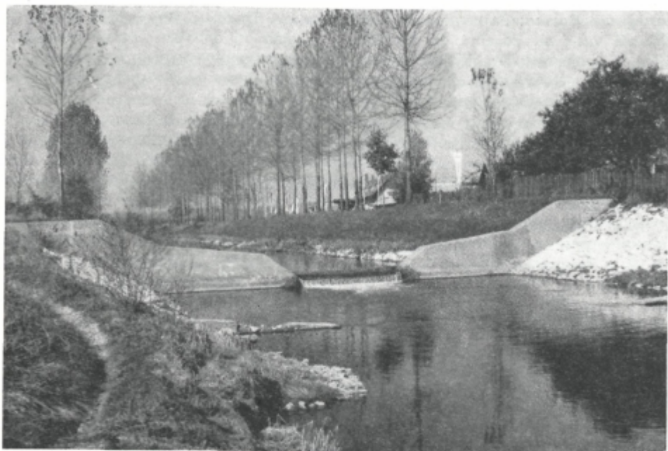
Sl. 9. Vzporedno z regulacijskimi deli na Ložnici (1954—1964) so zgradili v njeni strugi večje število betonskih pragov. Njihova vloga je vsaj dvojnega pomena: zmanjšujejo in urejajo strmec regulirani reki, obenem pa neposredno vplivajo na gladino talnice
