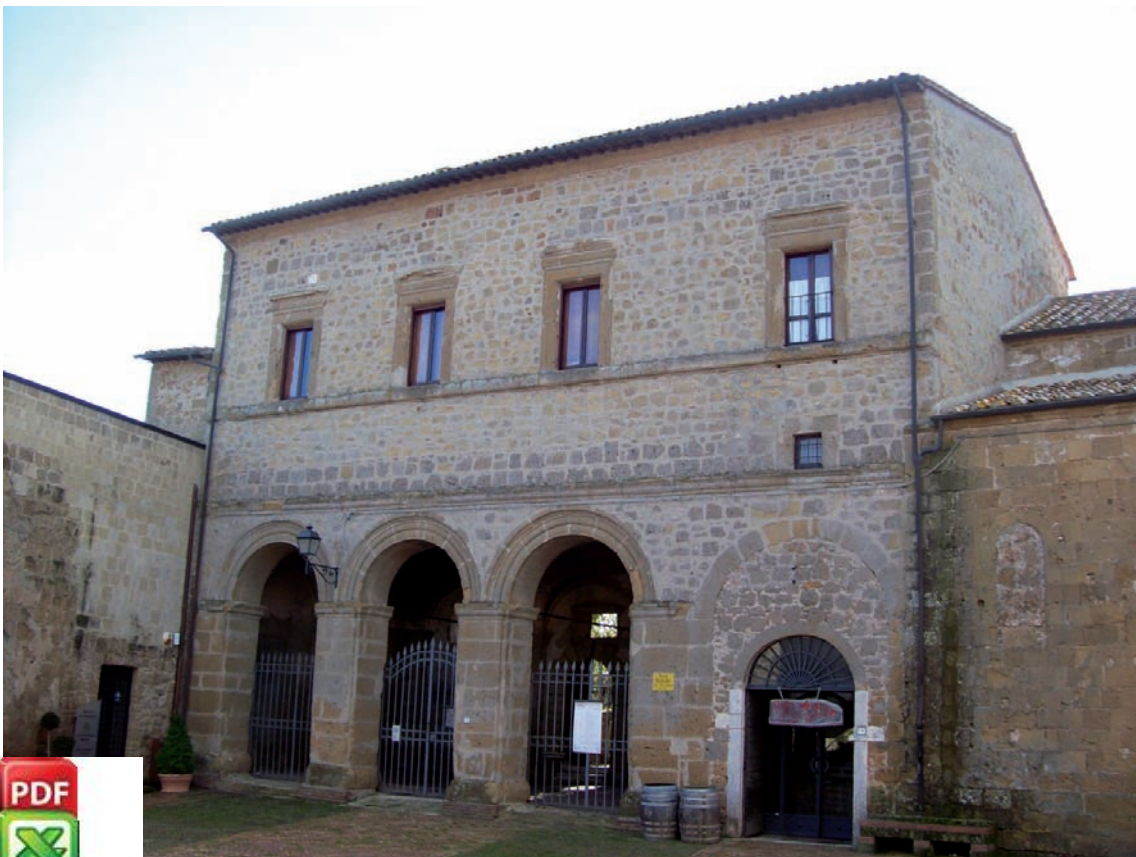
Sovana, Palazzo Bourbon del Monte dopo il recente restauro.
