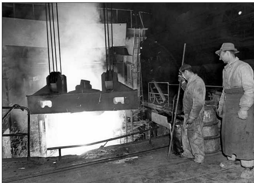
Odlévání na Ocelárně 2 huti Poldi
