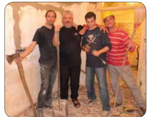
Renovierungsarbeiten im „Häferl“
