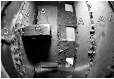
Rys. 8. Dodatkowe wzmocnienia wspawane wewnątrz belki
