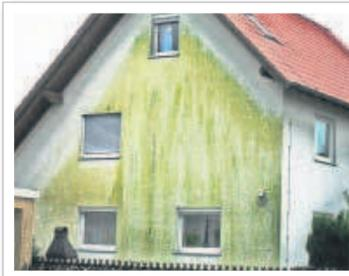
**Unansehnliche gedämmte Häuserfassaden mit Algen- und Schimmelbefall:** Durch die alltägliche Lüftung von Haus und Wohnung gelangen gefährliche Sporenträger in die Raumluft, dort können sie verschiedene Atemwegserkrankungen auslösen
