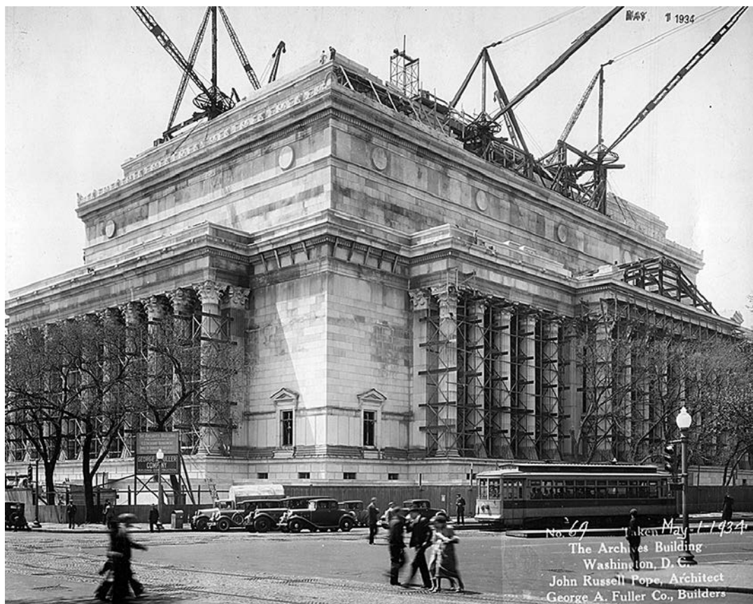
Спорудження будинку Національного архіву США, 1 травня 1934 року
