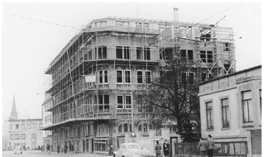
Möbelhaus Frey an der Kaistraße im Bau
