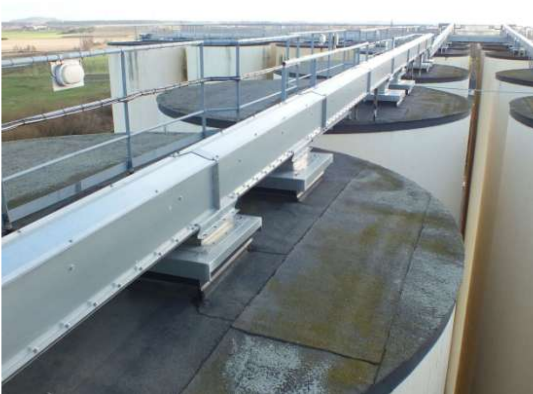
Foto Regionmuseet Kristianstad: Silocellernas tak samt ovanliggande transportsystem.
