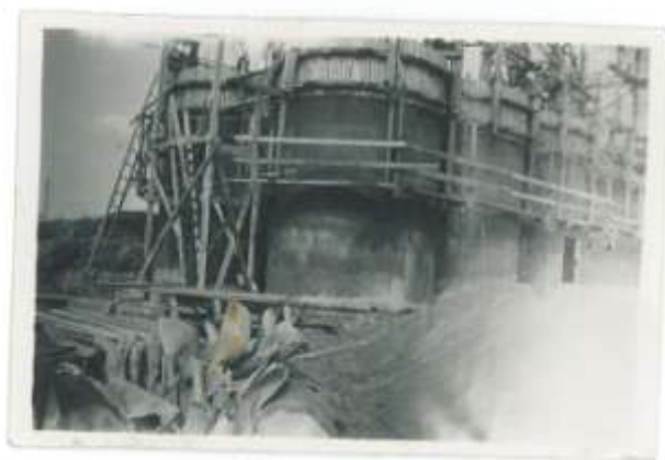
Dalby silor under uppförande i glidjuten betong 1953. (Bild privat fotografi Kenth Mårtensson)
