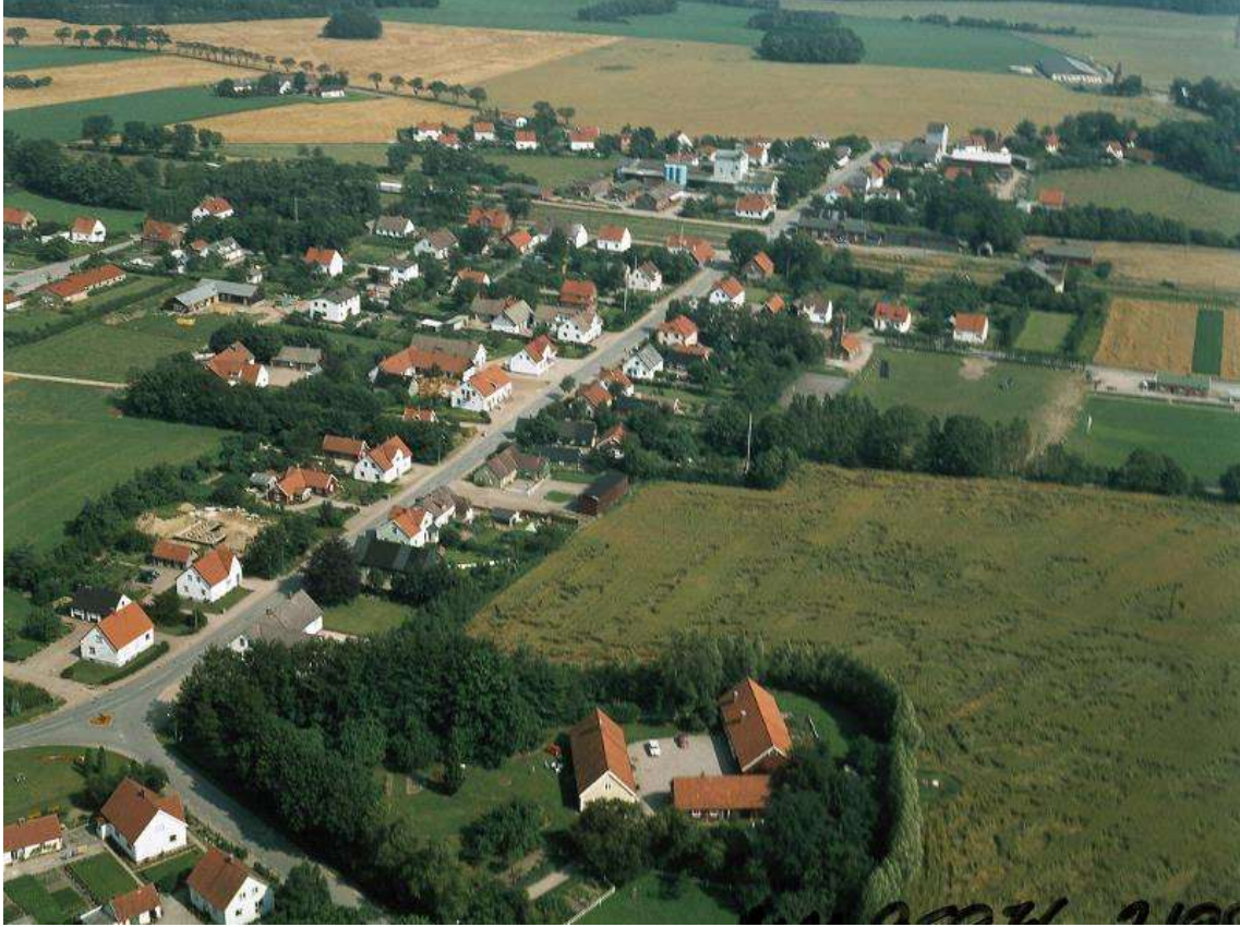
Spannmålsanläggningen syns på flygfoto (1938-1988) som sista byggnaderna på vänstra sidan om vägen.
