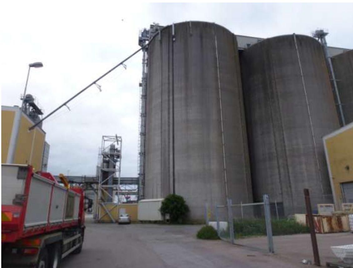
Foto Kulturen. De tre betongsilorna som idag ägs och brukas av Svenska foder. Intaget där man tippar spannmålen finns i den gula plåthallen till höger i bild och mottagning med våg och provtagning till vänster i bild.
