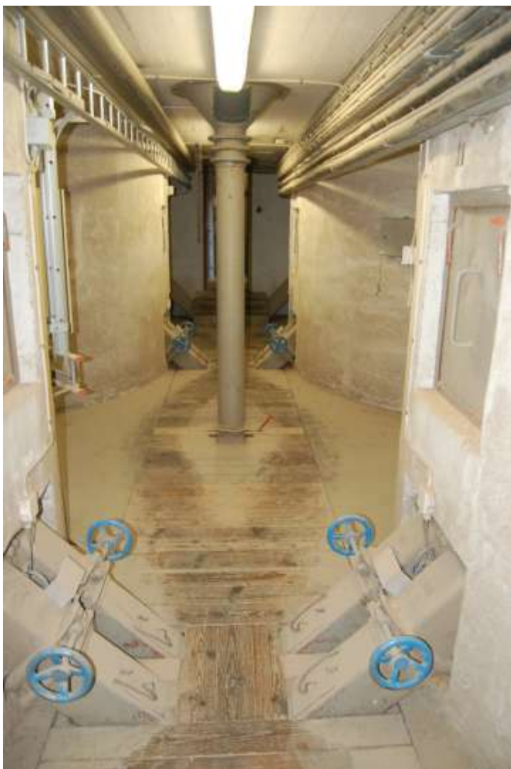
Foto Malmö Museer. Mellan silocellerna i bottenplan. Under golvet går ett transportband.
