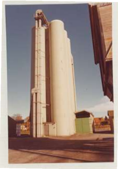
Foto: Lantmännen, 1970-talet. Silon sedd från söder med det första intaget till höger i bild. Här finns ännu inte lanterninen i dagens utförande på toppen och silon är ljus eller vit, inte grön som idag. Höger: Utlastningsstation för lösgödsel. Lösgödsel kom till exempel från SUPRA i Landskrona. Det tippades i en grop i marken och fördes upp i silon med transportbandet till höger. När man skulle lasta lösgödsel kördes vagnen in under behållaren.
