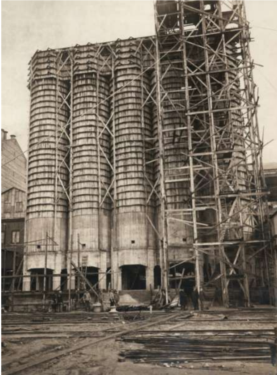
Byggandet av Mårten Pehrsons silor i Landskrona, troligen sent 1910-tal eller tidigt 1920-tal, glidgjutning användes inte. (bild Landskrona museum)
