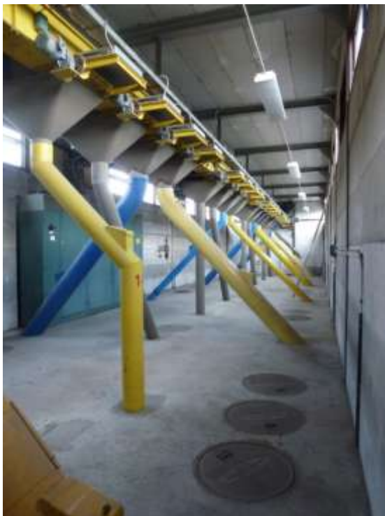
Lanterninen i Eslöv. Horisontell transportör med envägsfördelare och rör till de olika behållarna. Locken i golvet är lock till silorna. Färgerna på rören visar de parallella system som finns i anläggningen. Till höger aspiratör i Viderups silo.
