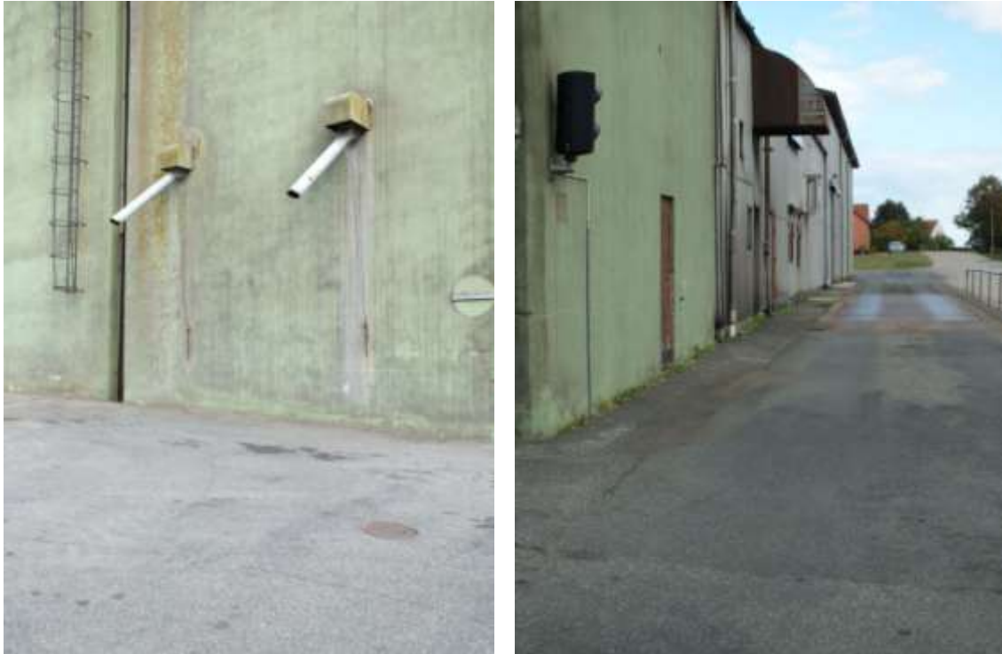
Foto: Regionmuseet Kristianstad: Till vänster detalj av silovägg med rör för utlastning av spannmål. Till höger siloanläggningens fasad ut mot Lantmannagatan. I fonden syns invägningen. Notera också ljussignalen på väggen, en viktig funktion när det under säsong kom många transporter för lossning av spannmål.
