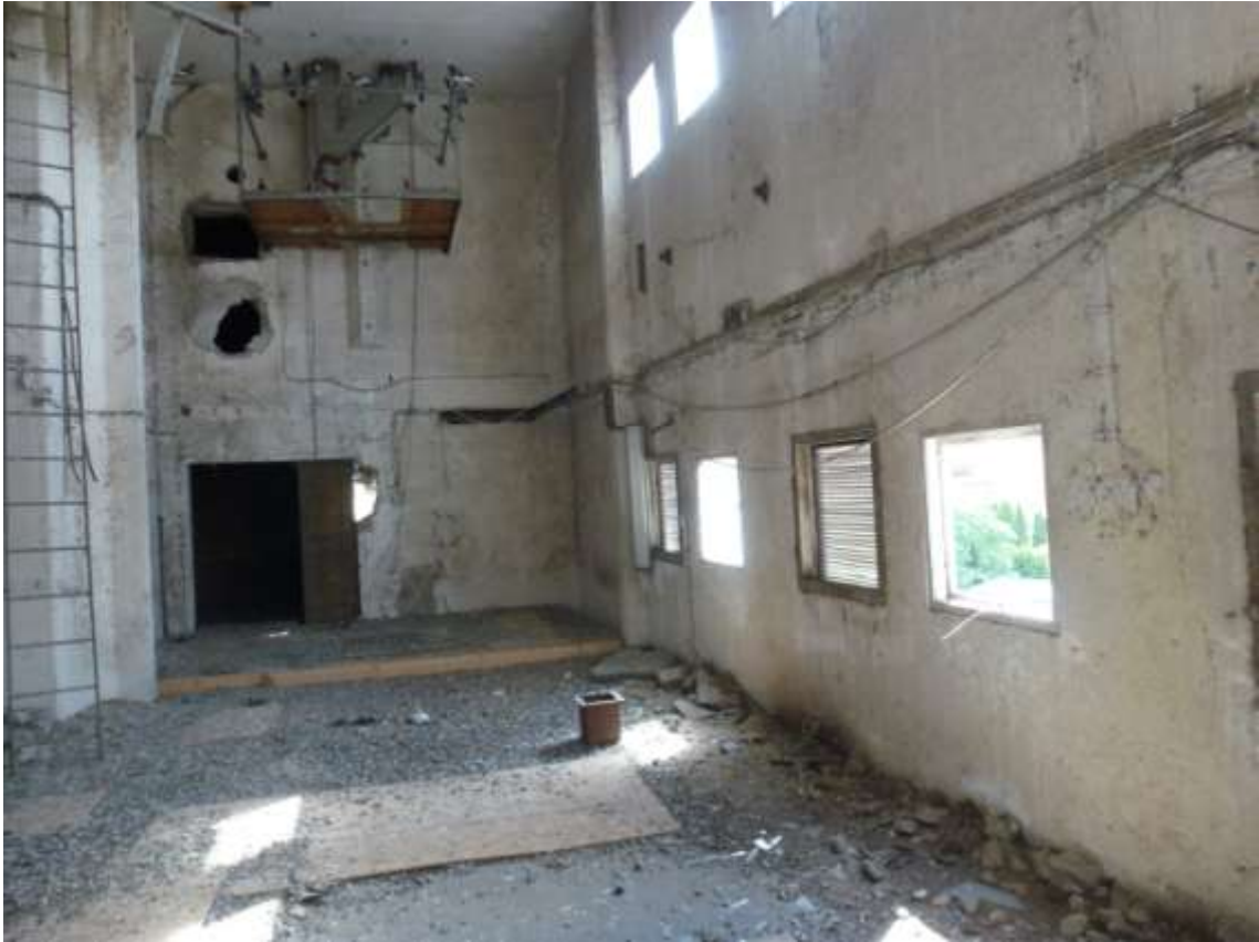
I den nedlagda silon är maskineriet utrivet. På grund av trasiga fönster har fåglar tagit sig in och smutsat ner.
