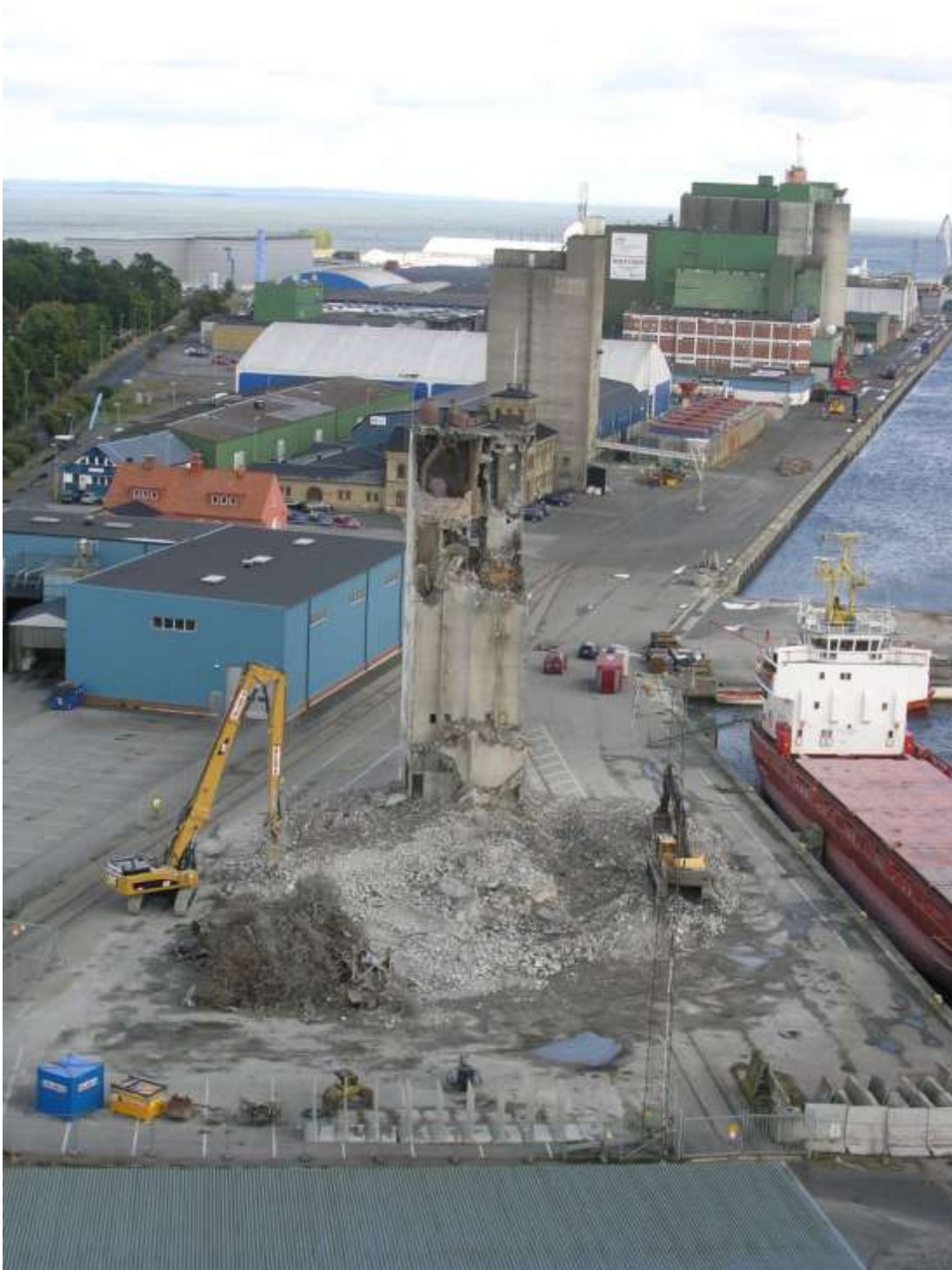
Foto Regionmuseet Kristianstad: Vi från KLF: s anläggning under rivningen av den silo som köpts in för att möjliggöra nybyggnation i form av kontor, labb och personalutrymmen.
