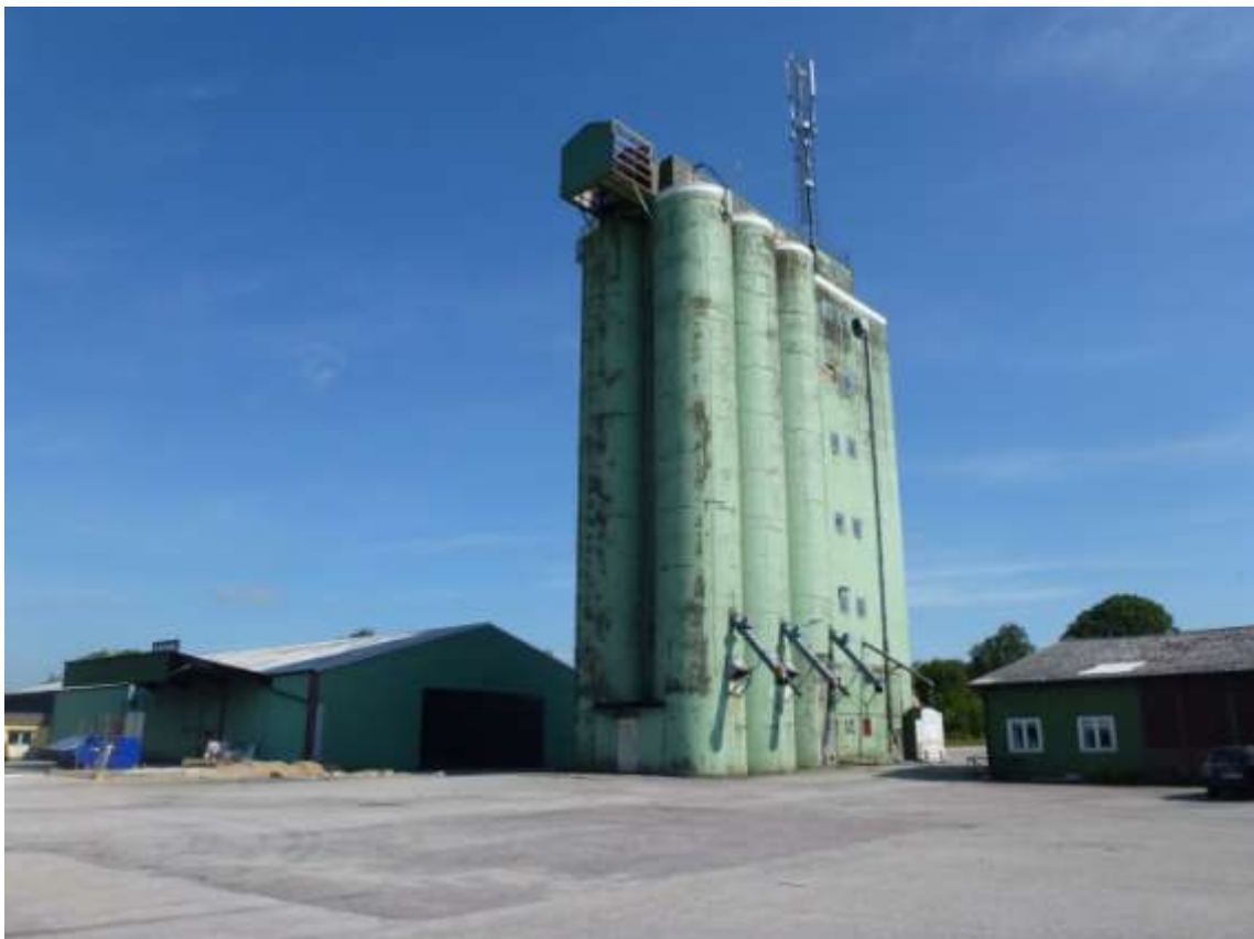
Foto Kulturen. Silon sedd från söder från den asfalterade ytan där spannmål tippades under högsäsong. Utlastningen skedde genom rören på silotornen. Till vänster i bild Lantmännens lager och butik. Till höger i bild det före detta trävarulager.
