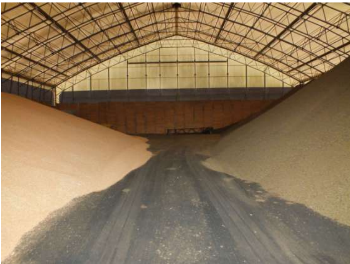
Foto Regionmuseet Kristianstad: Planlager för biprodukter som används i produktion av djurfoder. Till höger i bild ligger så kallade rapskakor och väntar på att bli del i foder. Byggnaden har en stomme av stål som är klädd med kraftig tältduk. Planlagring fungerar upp till två månader, därefter måste råvaran tas om hand i produktionen.
