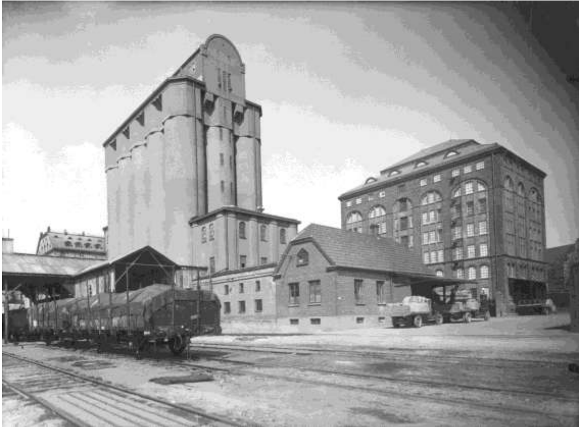
Betongsilor vid Mårten Pehrsons valskvarn, Kristianstad (Bild Regionmuseet Kristianstad). Datering oklar.
