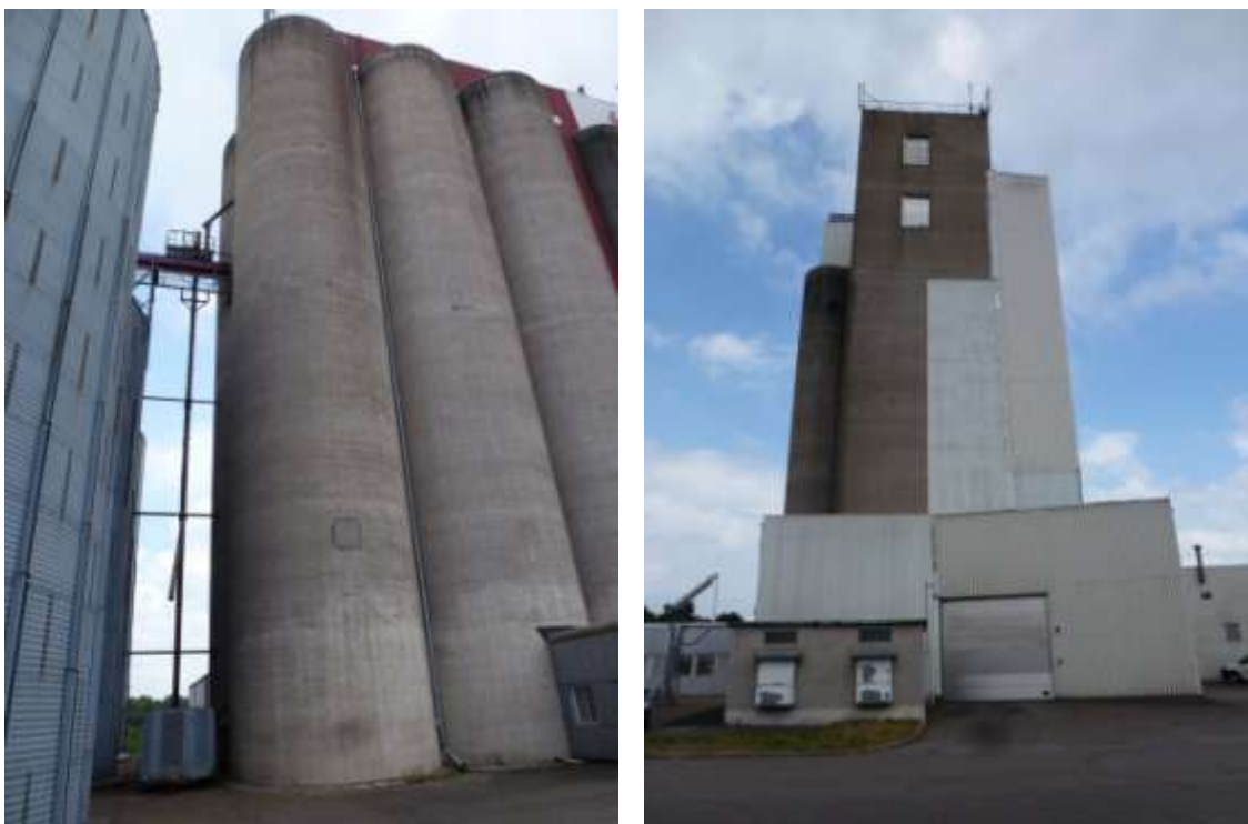
Foto Kulturen. Plåtsilor och betongsilor. Till höger: Maskintorn och plåthallar.
