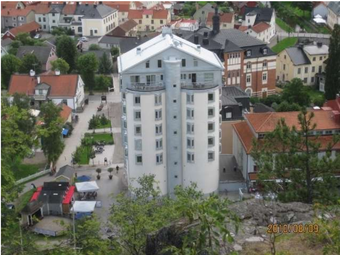
Silon i Söderköping efter ombyggnad.
