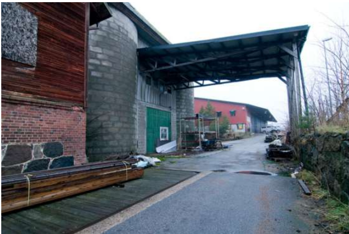
Foto Helen Carlsson, Höörs kommun: Silobyggnadens skärmtak som skydd över inlastningsfickan.
