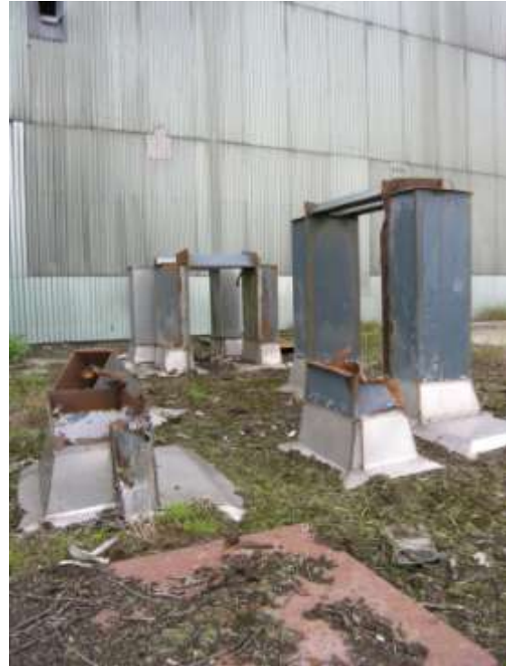
Foto Regionmuseet Kristianstad: Till vänster vattenfyllt hål som skapats efter att två stora siloceller revs. Till höger stålfundament som blivit kvar då silorna demonterades.
