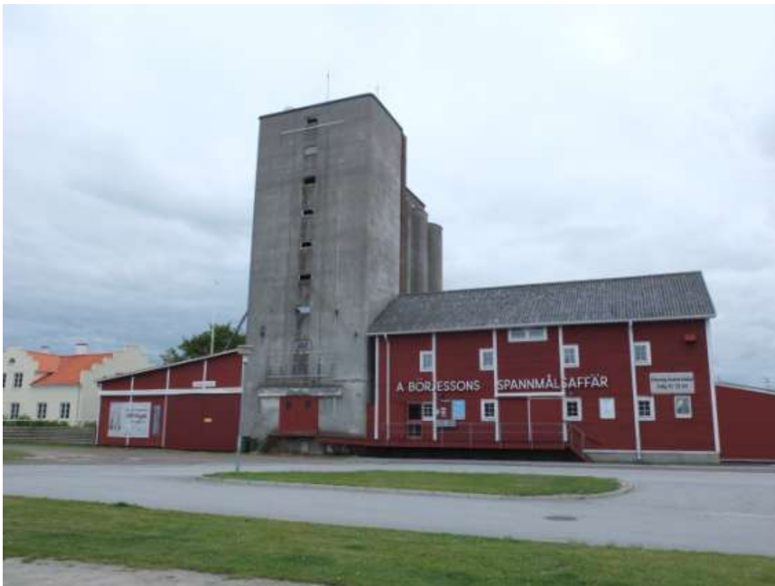
Foto Malmö Museer. Betongsilo med maskintorn och magasin i trä.
