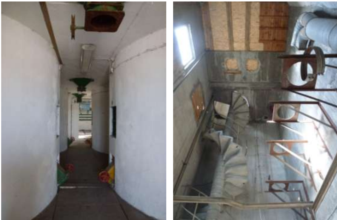
Foto Kulturen. Botten av silocellerna med gröna och gula luckor till transportbandet under golvet. Höger: Betongtrappan mellan de olika våningsplanen och hål efter bortmonterad utrustning.
