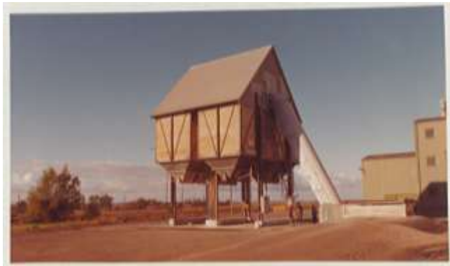
Foto: Lantmännen, 1970-talet. Silon sedd från söder med det första intaget till höger i bild. Här finns ännu inte lanterninen i dagens utförande på toppen och silon är ljus eller vit, inte grön som idag. Höger: Utlastningsstation för lösgödsel. Lösgödsel kom till exempel från SUPRA i Landskrona. Det tippades i en grop i marken och fördes upp i silon med transportbandet till höger. När man skulle lasta lösgödsel kördes vagnen in under behållaren.
