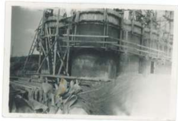
Silon underuppförande i glidgjuten betong. Källa: Privat fotografi Kenth Mårtensson
