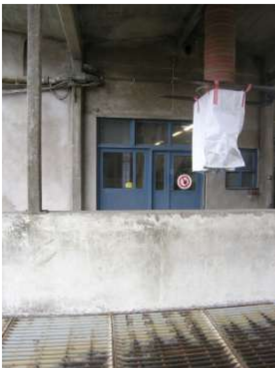
Foto Regionmuseet Kristianstad: Till vänster ingick till maskintorn och torkanläggning med intagningsgallret i förgrunden. Till höger markvåg för last invid planlagret i tegel.
