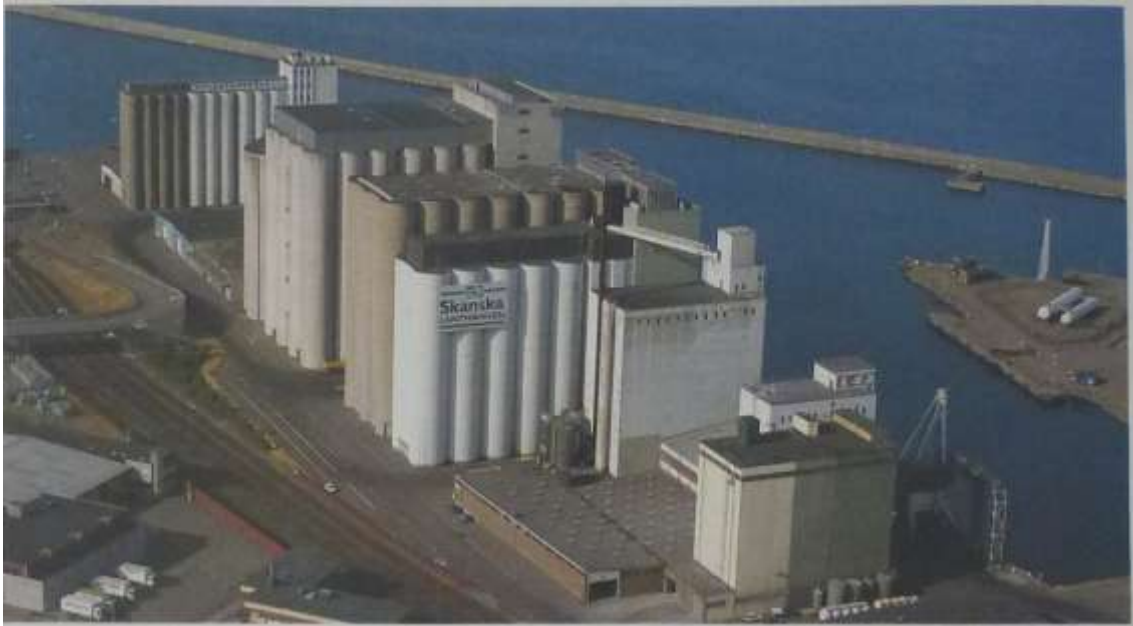
Foto: Lantmännen. Vy mot söder. På bilden är silorna ännu inte färgsatta i gula och beige nyanser.
