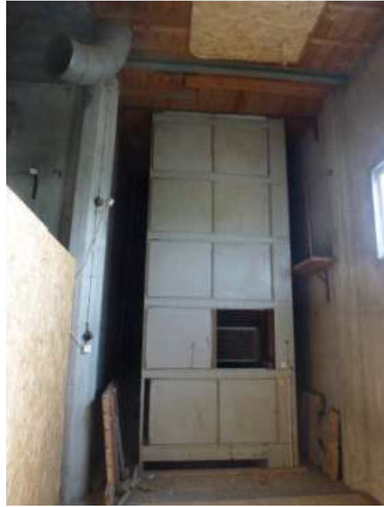
Foto Kulturen. Överst i maskintornet. Torkar och trissorna på golvet för den manuella manövreringen av luckorna mellan tork och silo. Höger: del av torken i maskintornet.
