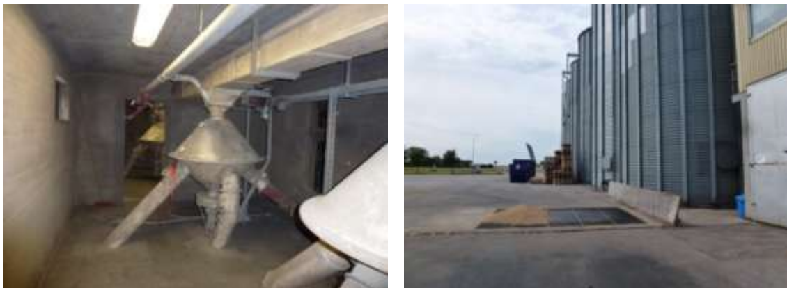
Foto Kulturen. Fyrvägsdelare på toppen av silorna i betong fördelar spannmål till cellerna. Intaget består av grop i marken försett med galler. På gallret ligger kvar lite spannmål som precis tippats av.
