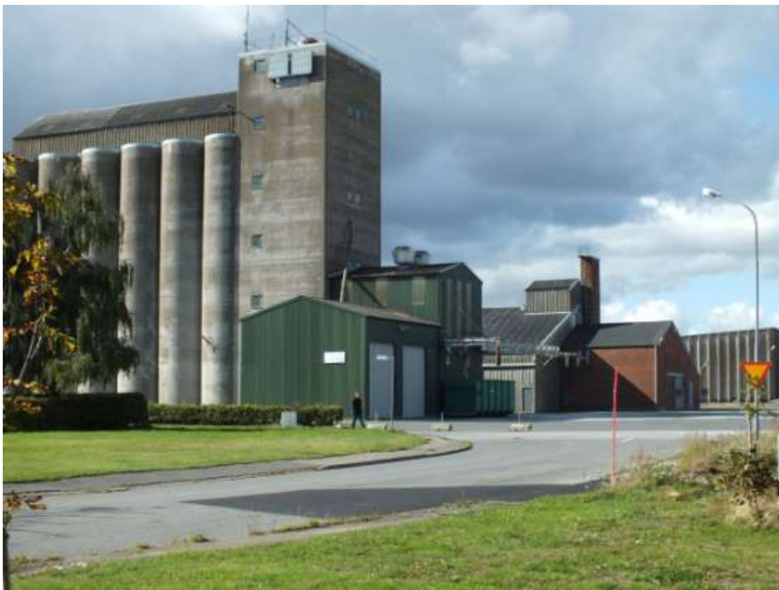
Foto Regionmuseet Kristianstad: Till vänster ingick till maskintorn och torkanläggning med intagningsgallret i förgrunden. Till höger markvåg för last invid planlagret i tegel.
