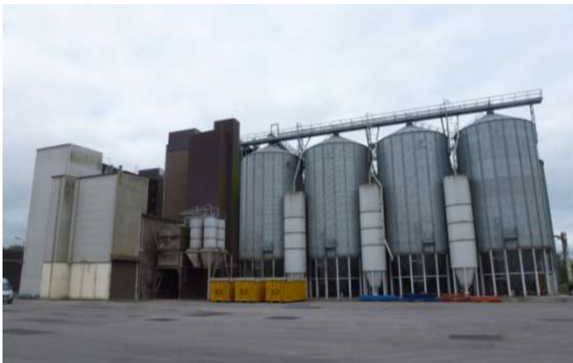
Foto Kulturen. Kvarn och silor i plåt.
