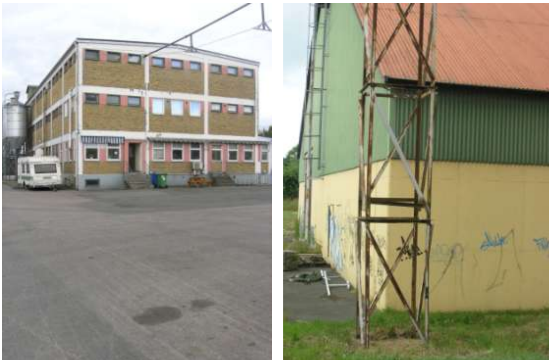
Foto Regionmuseet Kristianstad: Till vänster planlager med kontor och butik uppfört 1955. Till höger planlager från 1975, vilket ursprungligen skildes från resten av anläggningen genom järnvägen. Transport av spannmål går därför i rör högt upp i luften, därav den rostiga stålkonstruktionen.
