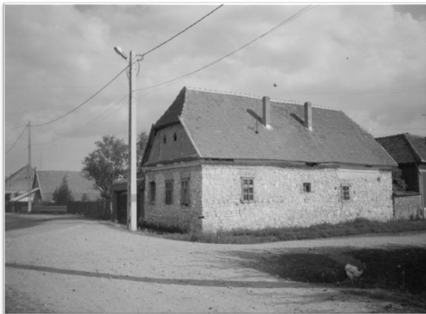
Casă de piatră, sec. XIX. Inițial construită ca han – cârciumă de drumul mare.
