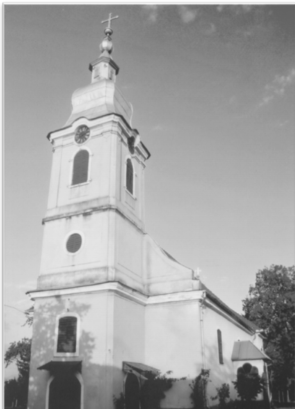
Biserica ortodoxă din Bârsa. Fațada.
