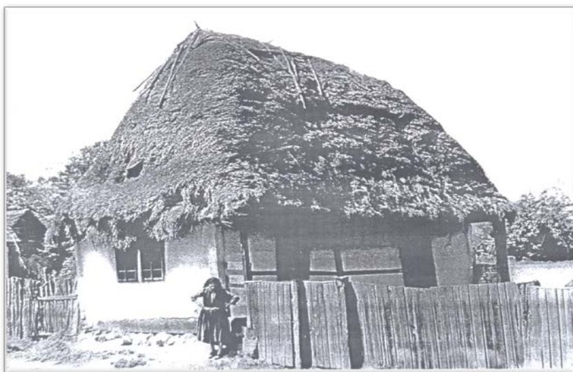
Casă din bârne de stejar, cu învelitoare de paie, construită în 1812, pe locul de la actualul număr de casă 51. A dispărut într-un incendiu din anul 1982
