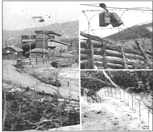
전방사단의 요새화된 GP 우측 위쪽은 구형 유자형 철조망 목책이고, 아래쪽은 신형 쇠고리 철조망 철책이다.
