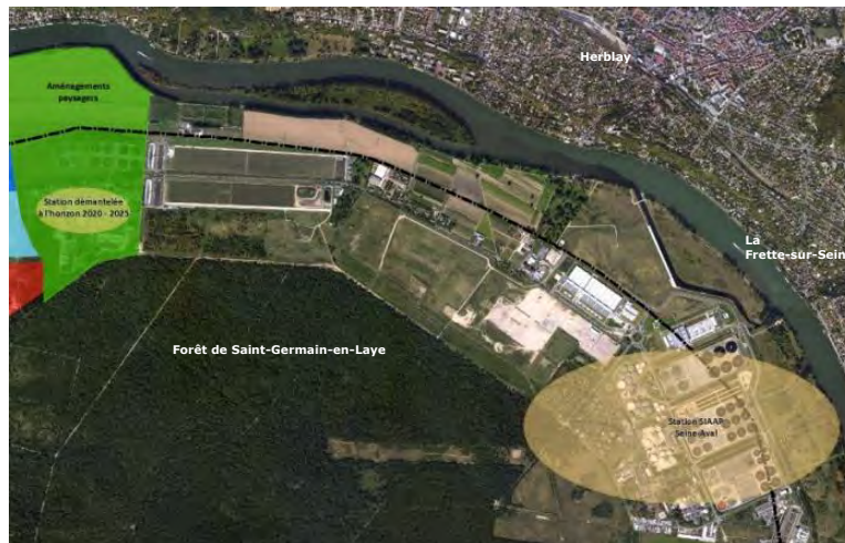
Figure 34 - Refonte de la station d'épuration Seine-Aval (Source : ville de Saint-Germain)
