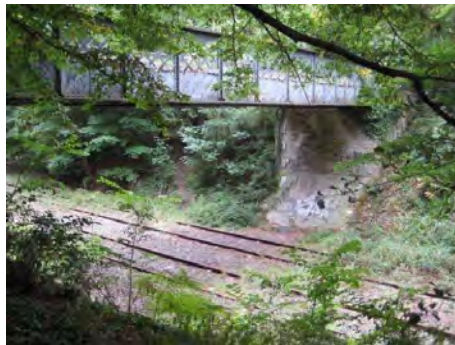
Figure 74 - Passerelle de la route de la Mare aux Bœufs (Source : études TGO Phase 2, Stif, 2008)
