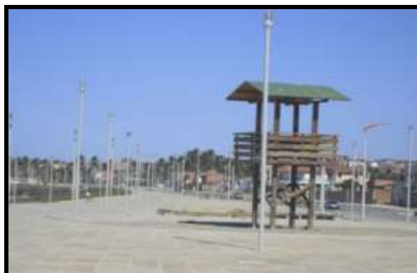
Figura 18: Infraestrutura implantada pós Projeto Vila do Mar
