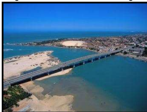
Figura: 5 Ponte José Martins Rodrigues
