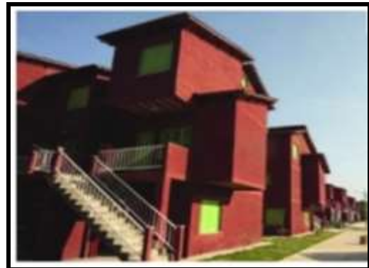
Figura 12 :Condomínios de reassentamento
