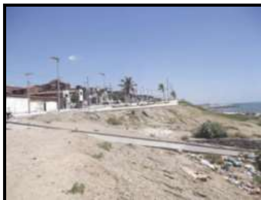
Figura 15: Urbanização das ruas próximas à praia
