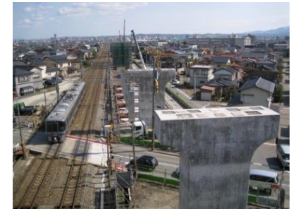
建設中（金沢八日市高架橋）
