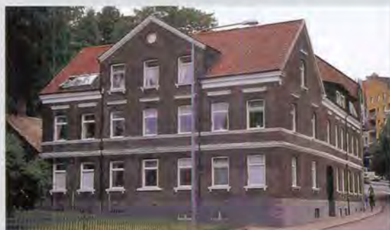
Biet 1 (hörnbyggnaden), Nedre Eneborgsvägen 3A
