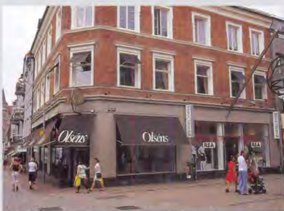
Delfinen 16 (del av), Kullagatan 27, Nedre Långvinkelsgatan
