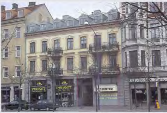
John Ericsson 4, Järnvägsgatan 27
