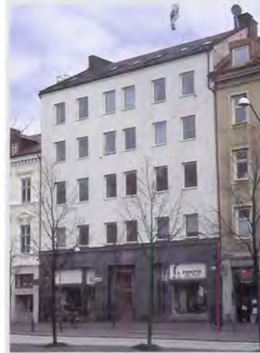
John Ericsson 2, Järnvägsgatan 23
