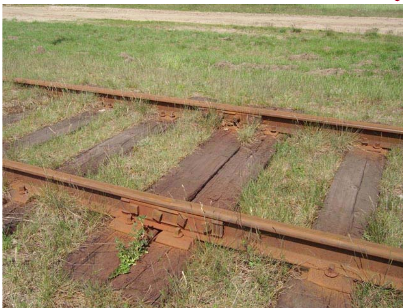
Fot. 12: Styk podparty z przytwierdzeniem bezpośrednim w torze typu 8, maj 2007 roku.
