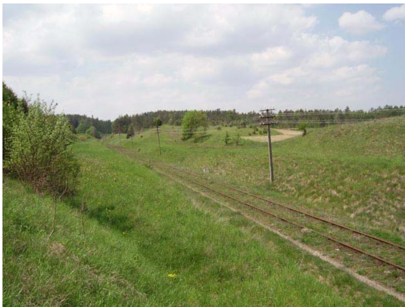
Fot. 9: Przekop tuż za stacją Lipusz, maj 2007 roku.
