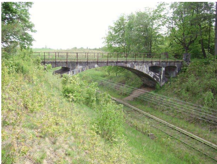
Fot. 16: Łukowy wiadukt betonowy nad torem w okolicy Lipusza, maj 2007 roku
