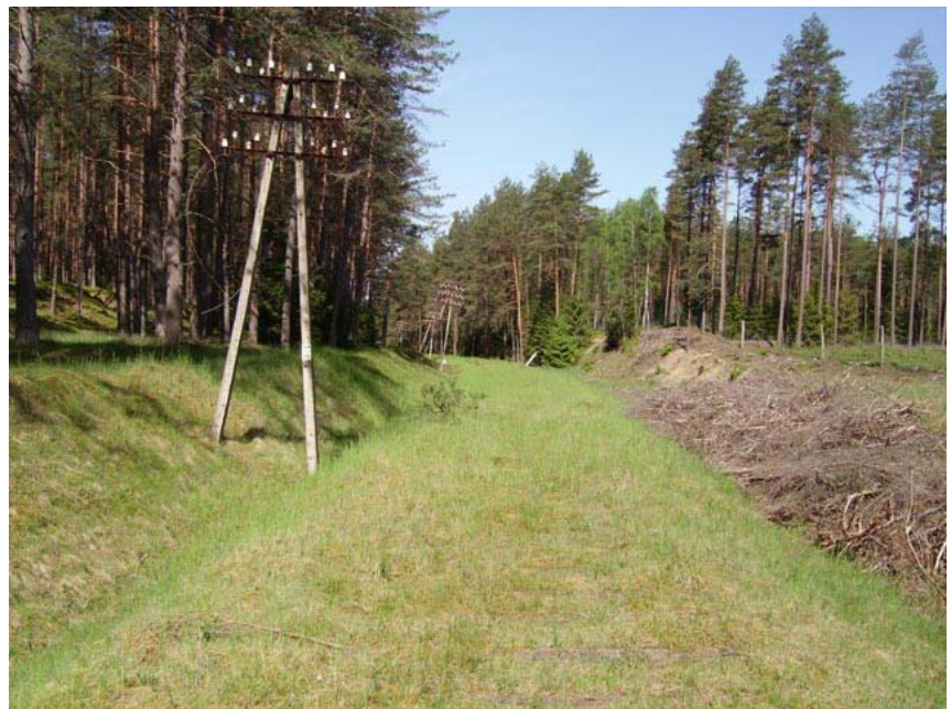
Fot. 24: Całkowity brak nawierzchni na skutek kradzieży w okolicy km 40,400, maj 2007 roku
