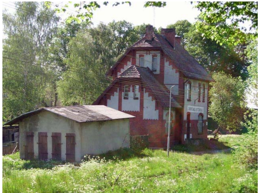
Fot. 50: Budynek stacyjny w Dąbrówce Bytowskiej, maj 2007 roku
