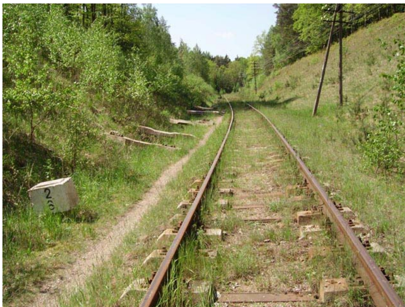
Fot. 14: Miejsce wymiany podkładów na staroużyteczne – km 2,600, maj 2007 roku
