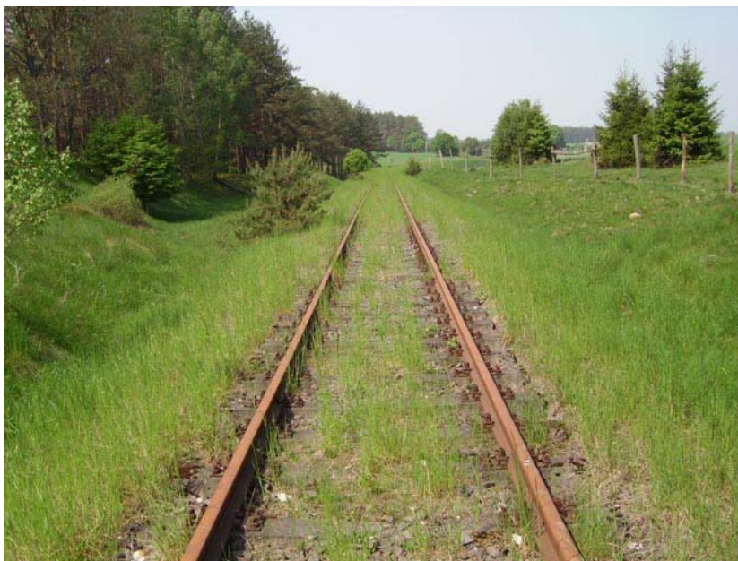
Fot. 20: Szyny S49 na podkładach betonowych między Zielinem Miasteczkim a Gumieńcem, maj 2007 roku
