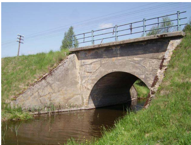
Fot. 17: Mostek betonowy nad rzeczką koło jeziora Imienie, maj 2007 roku
