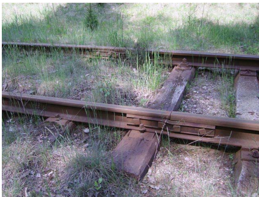
Fot. 6: Przejście między szynami S49 a typu 8 w km 2,600, maj 2007 roku.
