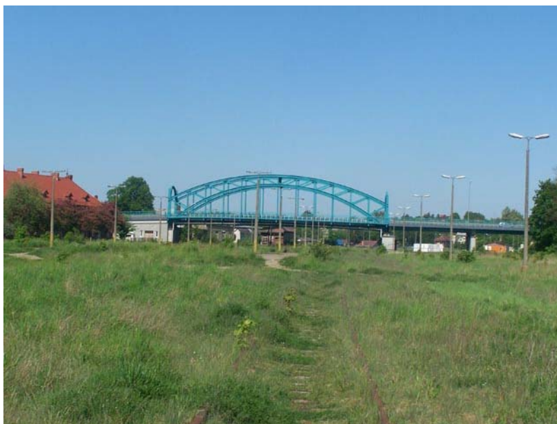
Fot. 68: Widok ogólny na stację w Bytowie, maj 2007 roku
