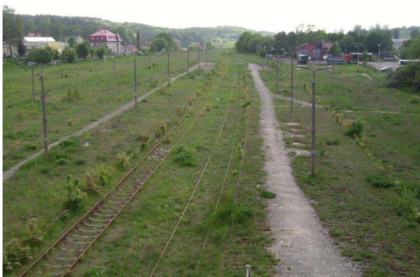
Fot. 48: Widok ogólny na stację w Bytowie, maj 2007 roku
