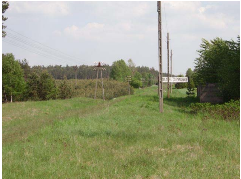
Fot. 41: Widok ogólny na przystanek Ośława Dąbrowa, maj 2007 roku
