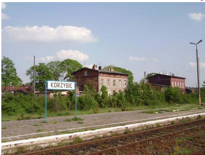
Fot. 64: Widok ogólny na dawną stację w Korzybiu, maj 2007 roku
