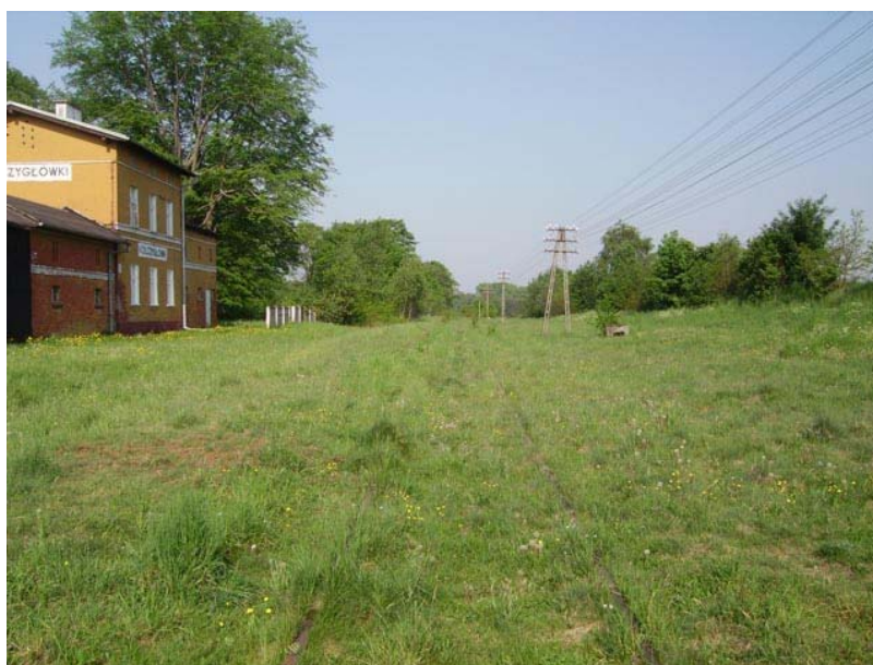
Fot. 56: Widok ogólny na dawną stację w Kołczygłówkach, maj 2007 roku
