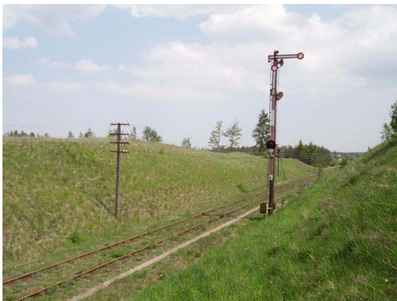
Fot. 18: Semafor wjazdowy do Lipusza od Strony Bytowa, maj 2007 roku
