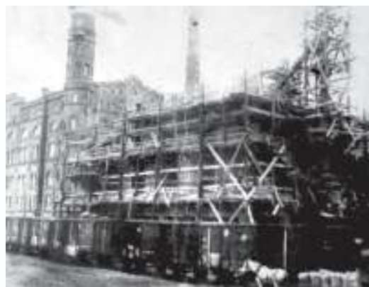
Студенты техникума на строительстве элеватора при мукомольном заводе № 52, 1928 г.
