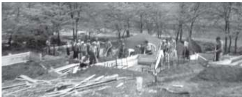
Строительство спортивно-оздоровительного лагеря «Дружба», 1959 г.
