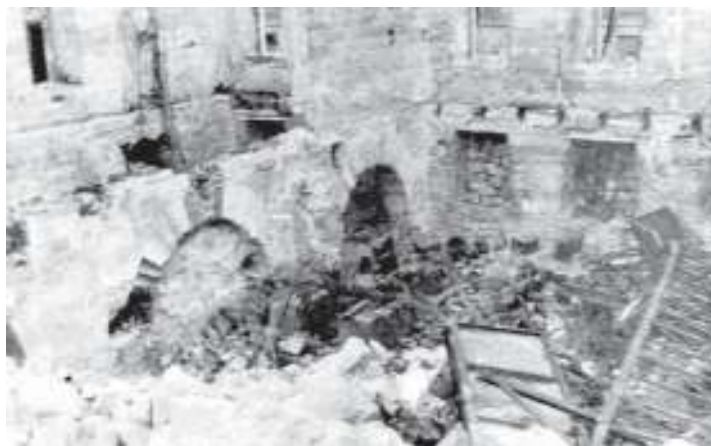
Разрушенная мельница, г. Одесса, июнь 1941 г.
