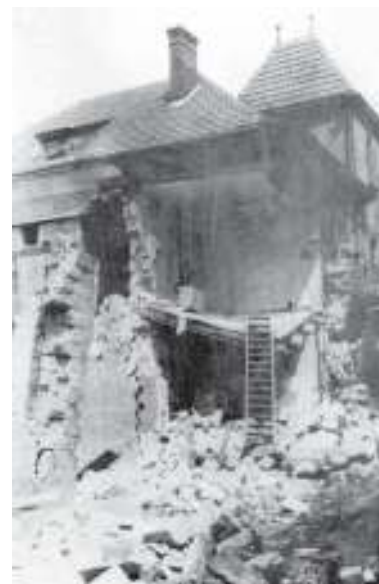
Дом преподавателей института по ул. Свердлова, 118, разрушенный 23 июня 1941 г.
