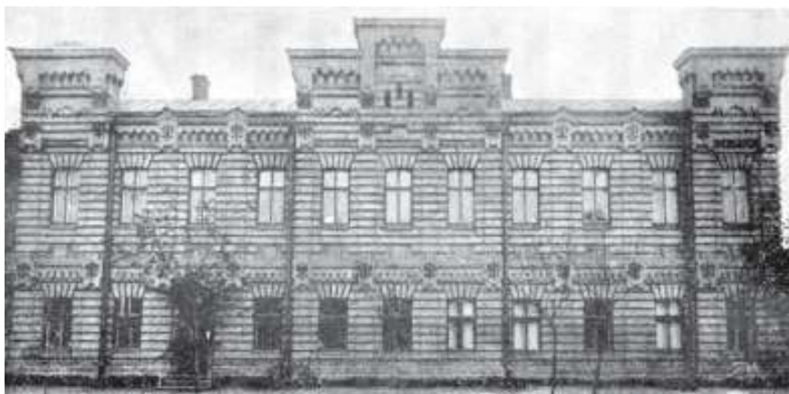
Фасад здания Одесской Школы мукомолов
