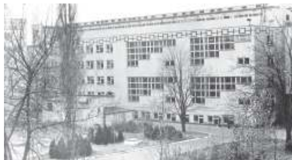
Новый корпус Д –химический
