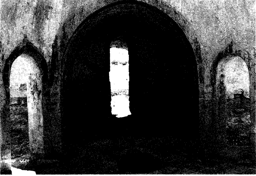
Resim 9: Hamamın sıcaklık bölümünün temizlenmiş hali ve yıkanma odaları
