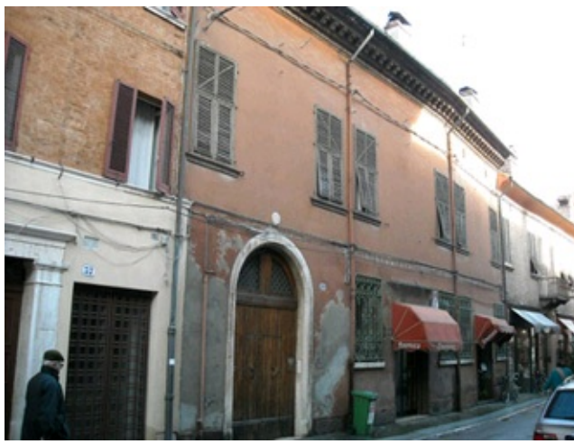
Casa di via Saraceno nn. 39-41
