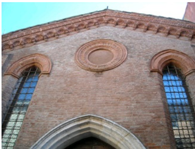
Ex chiesa dei Santi Simone e Giuda, particolari decorativi della facciata
