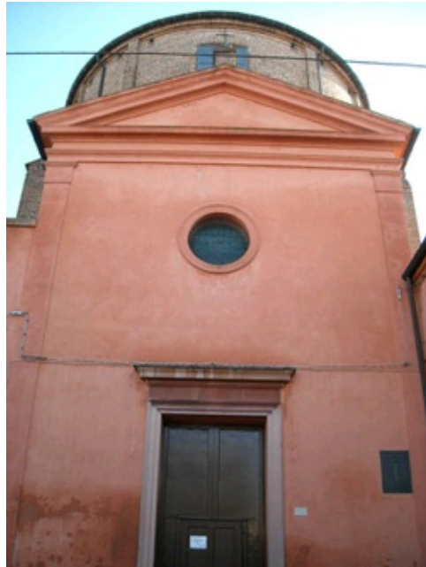
Chiesa di Santa Teresa Trasverberata, facciata
