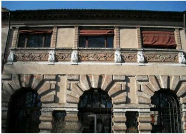
Palazzina dei Bagni Ducali, parte centrale del prospetto principale
