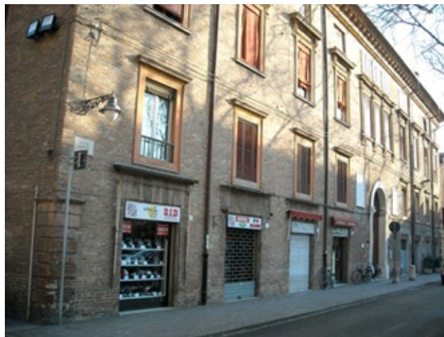
Palazzo Sacrati-Strozzi, facciata
