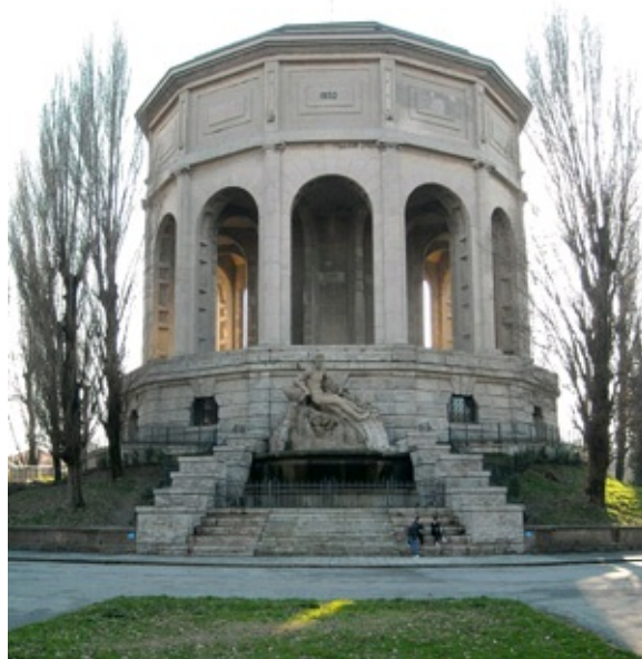
Serbatoio monumentale di Piazza XXIV Maggio
