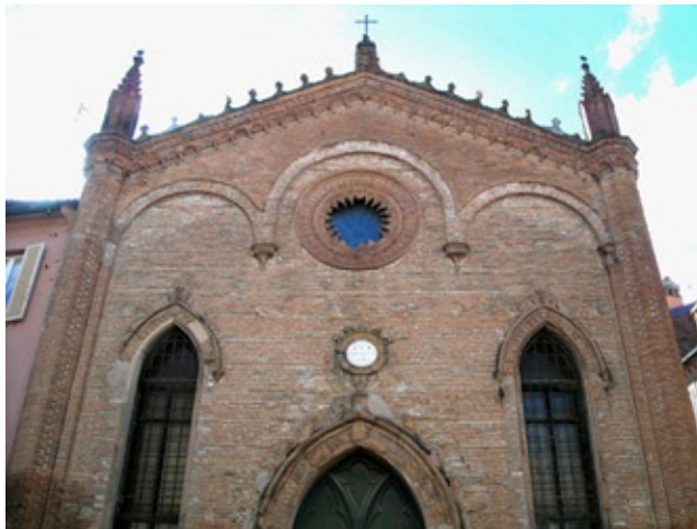
Chiesa di Sant'Antonio Abate, particolari della facciata
