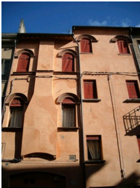
Casa di via Saraceno nn. 11-13
