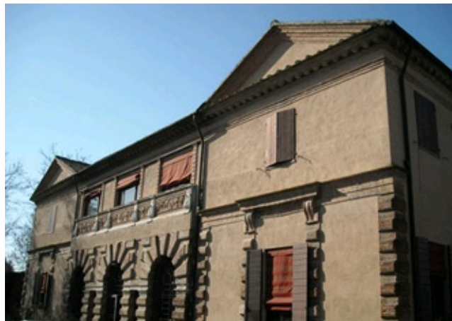
Palazzina dei Bagni Ducali, prospetto principale
