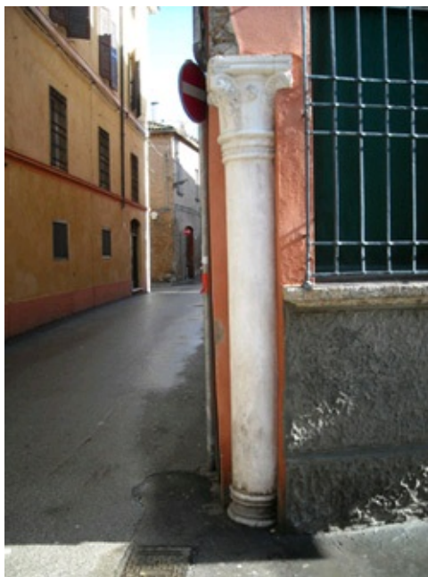
Abitazione in via Saraceno n. 101, colonna con capitello del XV secolo
