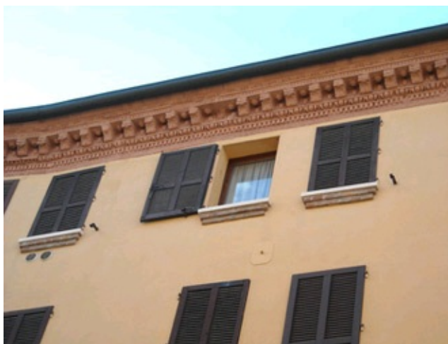
Casa di via Saraceno nn. 16-24
