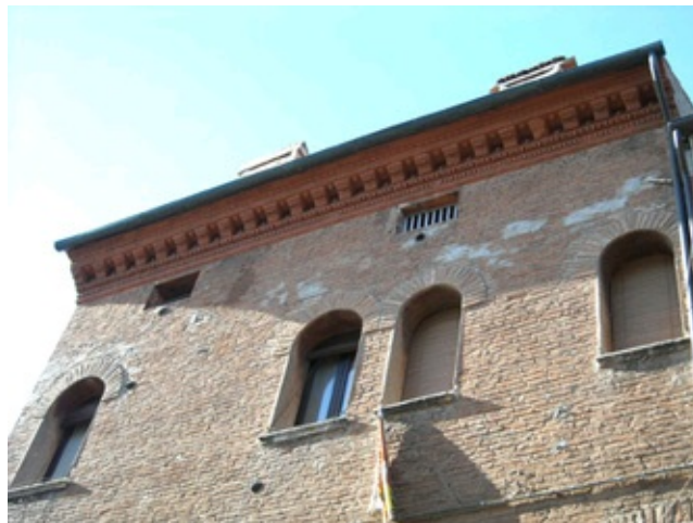
Via Saraceno nn. 104-106, finestre al secondo piano e cornicione rinascimentale
