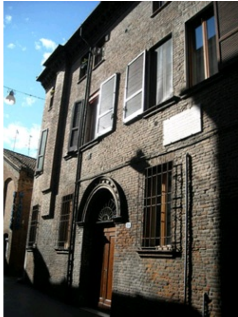
Casa Bottoni, prospetto in corrispondenza del n. 16
