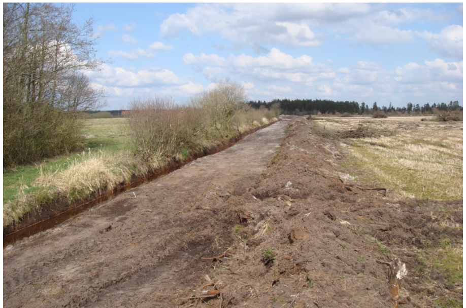
Grundig oprensning af grøft så langt øjet rækker
