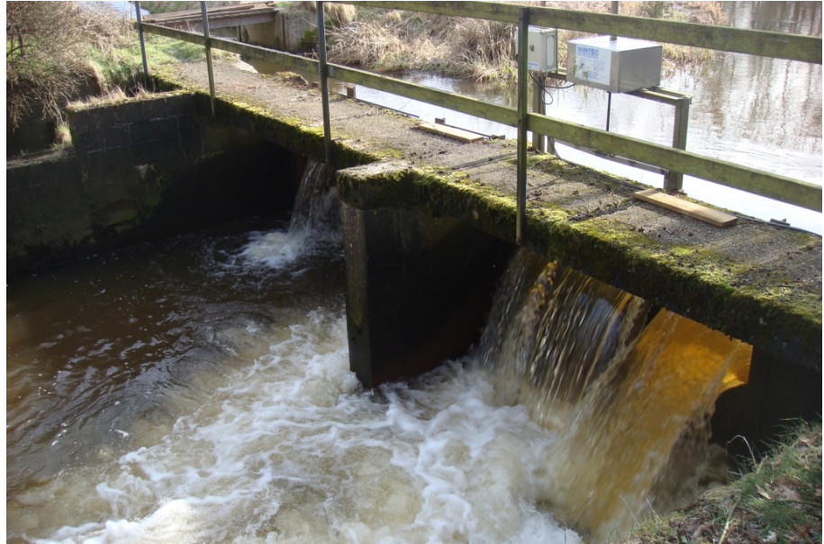
Overløb over stemmeværket ved Kideris Dambrug
