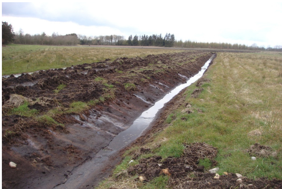
Tilløb af nyligt opgravet grøft med ringe vandføring
