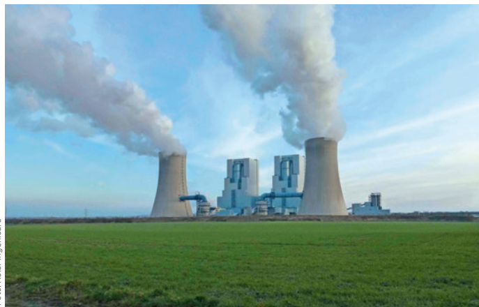
Foto: Köber Ingenieure
