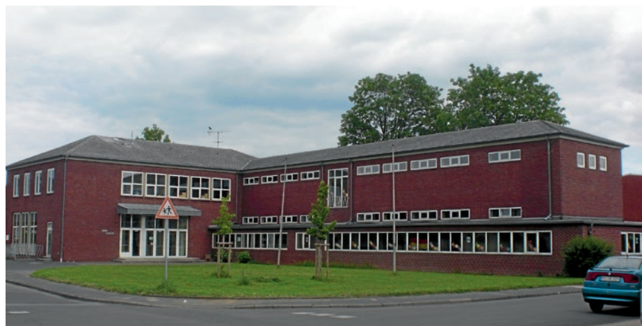
Grundschule an der Umlandstraße in Hückelhoven-Hilfarth, 1953 geplant
