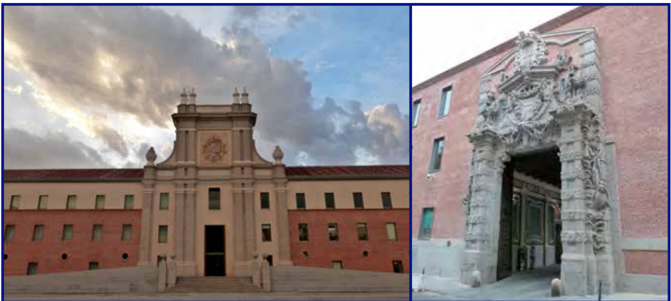
Cuartel del Conde-Duque, en Madrid, cuyas obras comenzaron en tiempos de Felipe V
