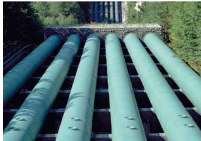
Das Wasserschloß hoch oben auf dem Berg und die sechs riesigen Druckrohre sind weithin sichtbares Markenzeichen des Walchenseekraftwerkes. Das Gewicht aller Rohre beträgt zusammen rund 3.600 Tonnen.
