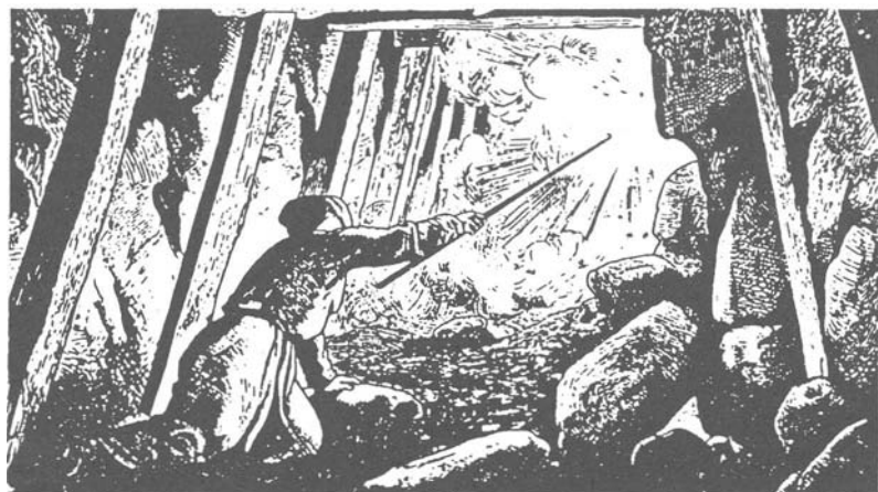
Abfeuern einer Sprengpatrone zu Beginn des 19. Jh.
