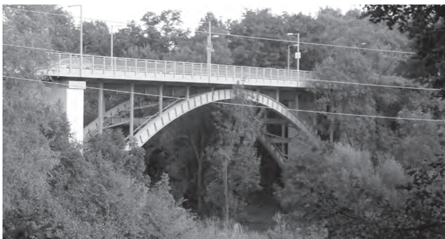
Tyršův most je prvním celosvařovaným ocelovým obloukovým mostem z roku 1933
