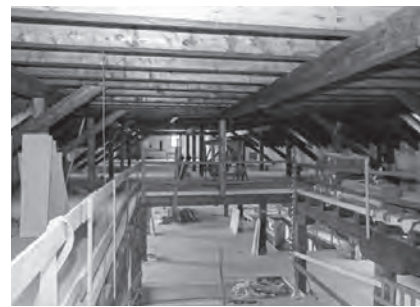
ČSSI a ČKAIT Olomouc uspořádaly v prosinci 2014 exkurzi do Pevnosti poznání UP, které se zúčastnilo cca 80 osob; na obr. je oprava krovu
