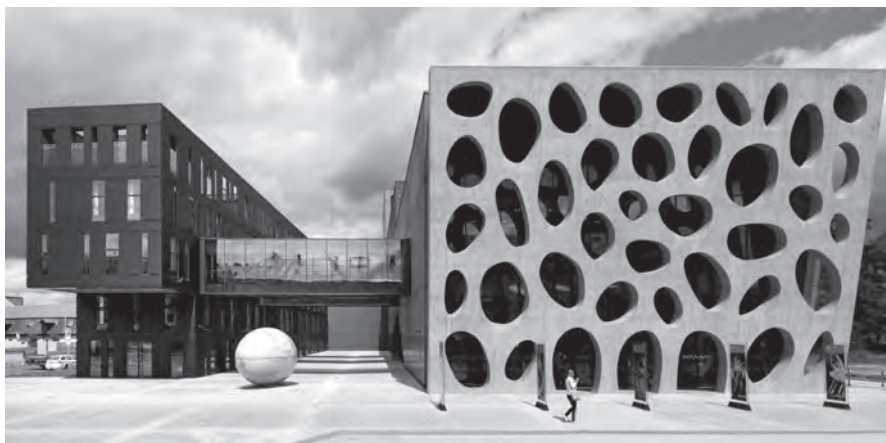
Nové divadlo v Plzni s perforovanou čelní fasádou z pohledového betonu (foto: HELIKA, a.s.)
