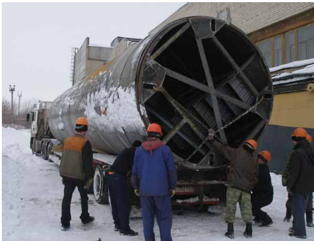
Отгрузка изготовленных металлоконструкций резервуаров
