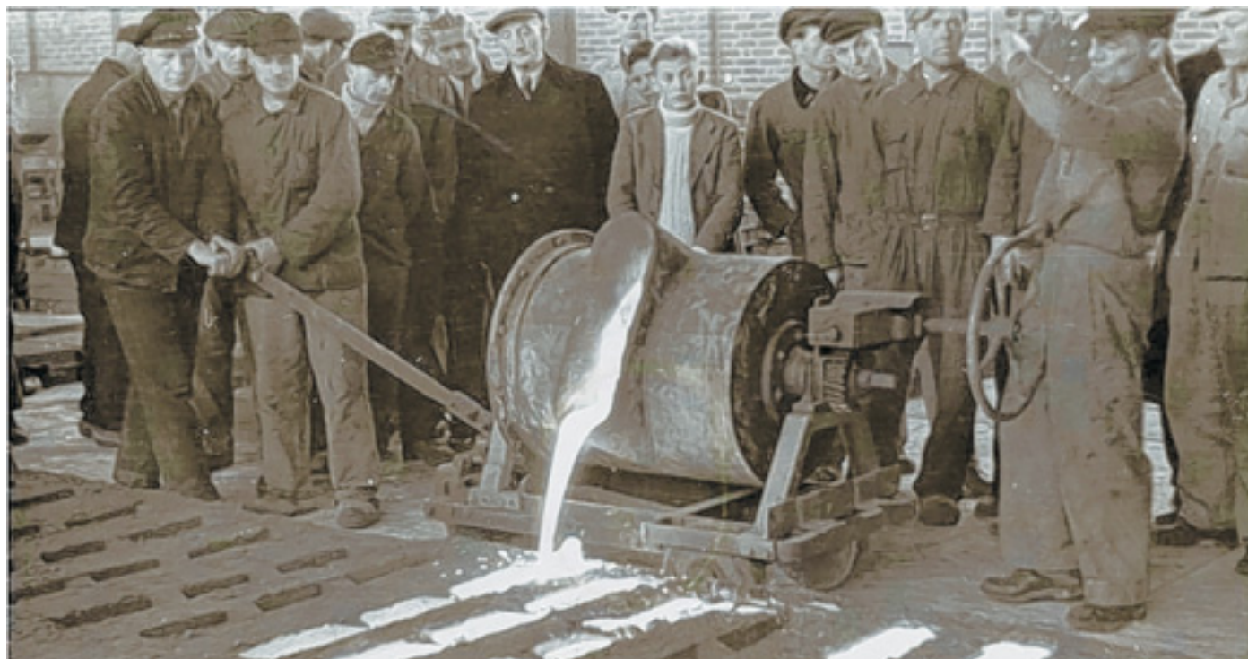
Anguss: Die erste Pfanne flüssigen Eisens aus dem neuen Hochofen der Karlshütte in Ahle wird in den Formsand gegossen – am 1. November 1949. Der Freie Presse-Fotograf Nolting hielt diesen Augenblick fest.
