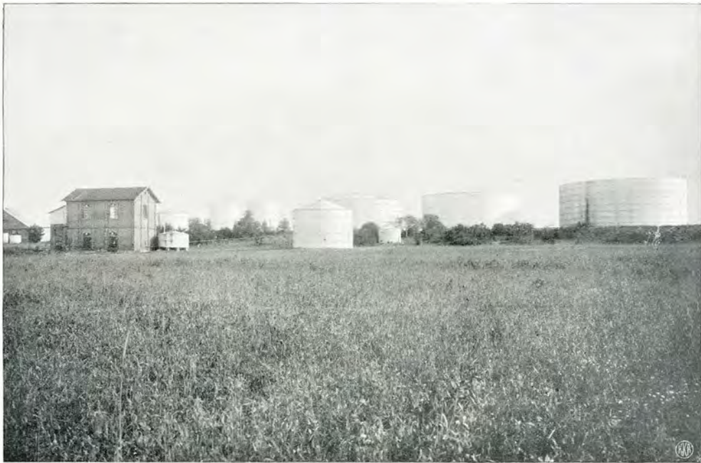
PARTI FRA TANKANLÆGGET
