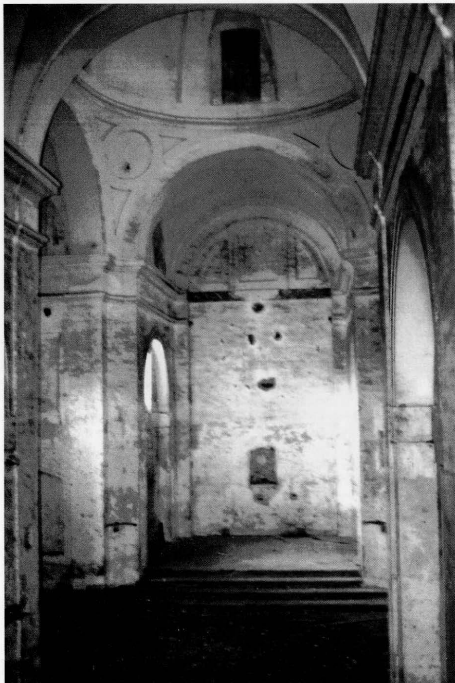
Fig. 7.—Convento de Velada. Interior hacia el testero
