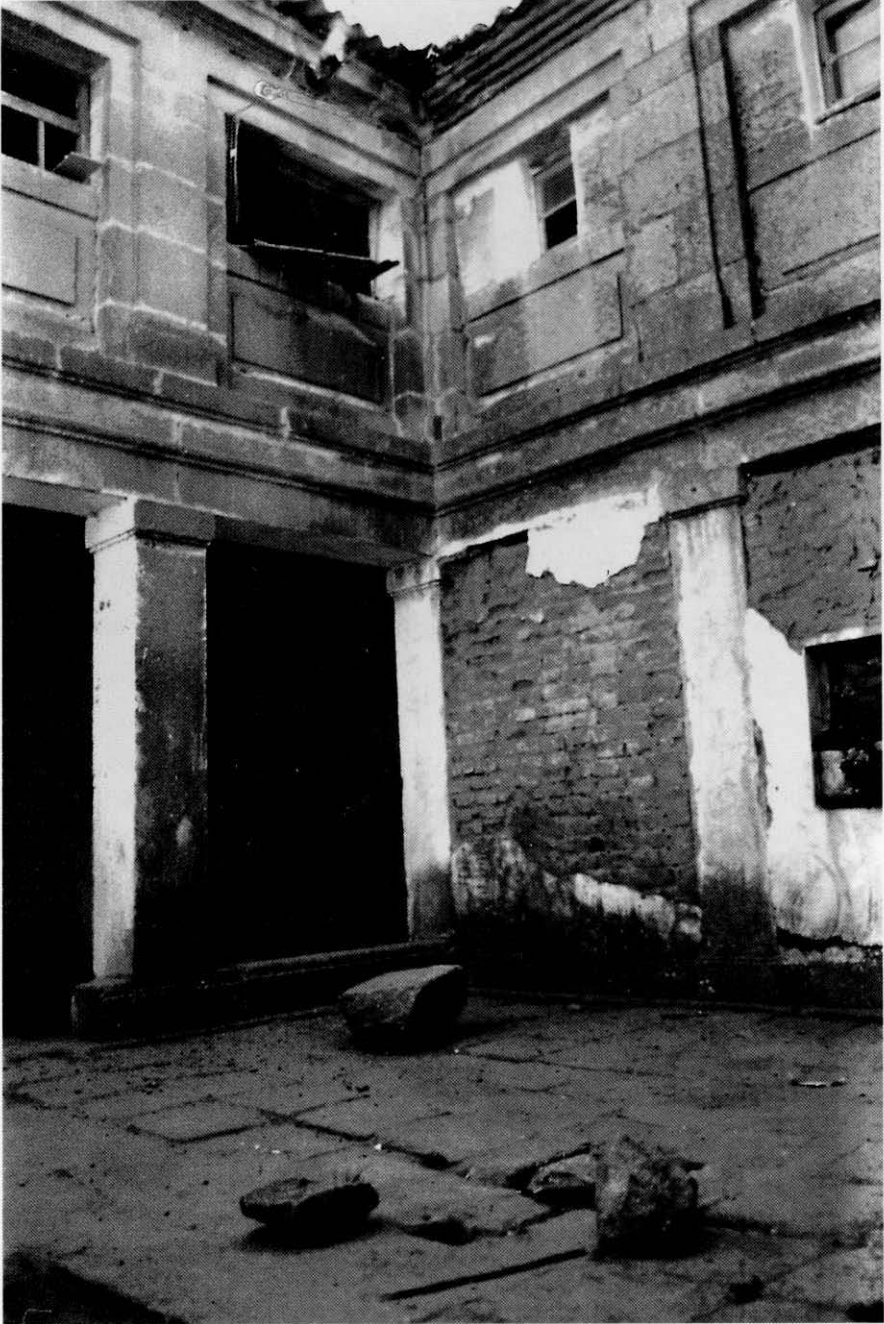
Fig. 5.—Convento de Velada. Patio
