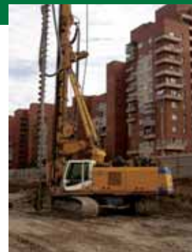
Строительство жилого дома в Кронштадте
