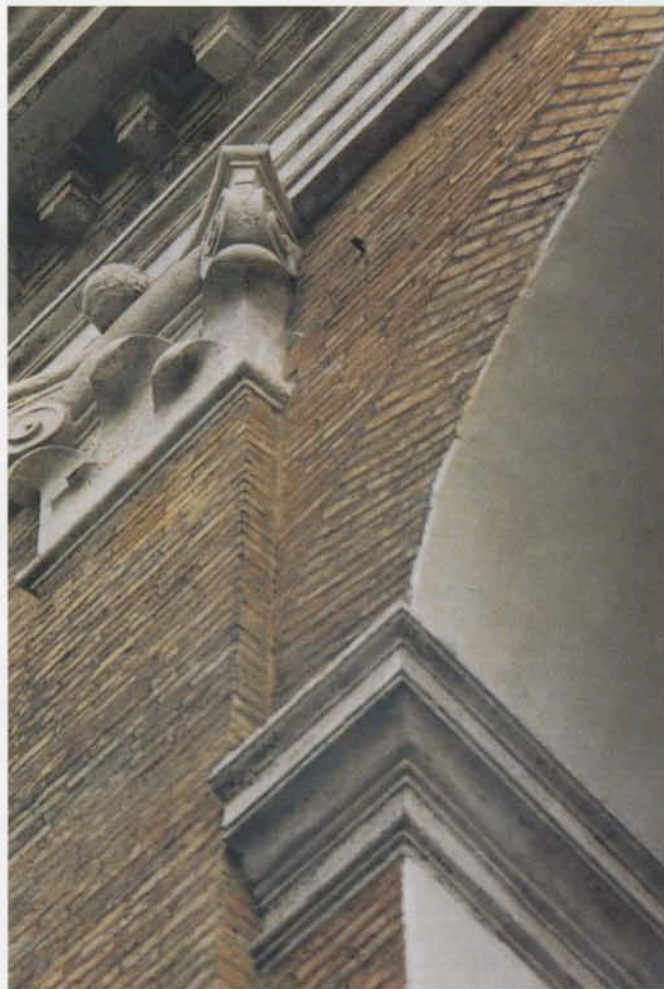
22 – PARTICOLARE DEL TRAVERTINO E DEL PARAMENTO LATERIZIO DOPO L'INTERVENTO
