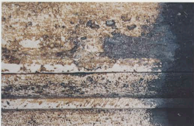
15 – SCIALBI COLOR OCRA SCURO EVIDENZIATI DALLA PULITURA DEL TRAVERTINO (foto S.E.I., 1998)
