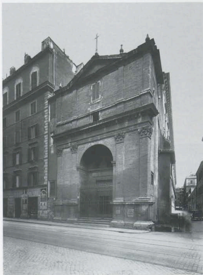
5 - ROMA, CHIESA DI SANTA MARIA IN PORTA PARADISI FACCIATA DELLA CHIESA (foto ICCD, 1937)
