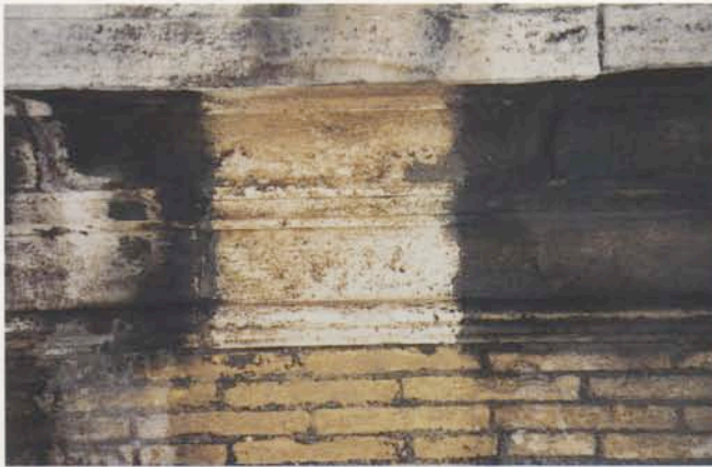
17 – SAGGIO DI PULITURA SUL TRAVERTINO DEL CORNICIONE (foto S.E.I., 1998)
