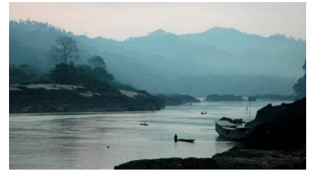
Nơi dự kiến xây đập cho dự án thủy điện Xayaburi ở Lào
