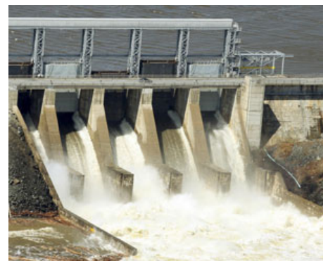
Đập thủy điện Mactaquac, Canada
