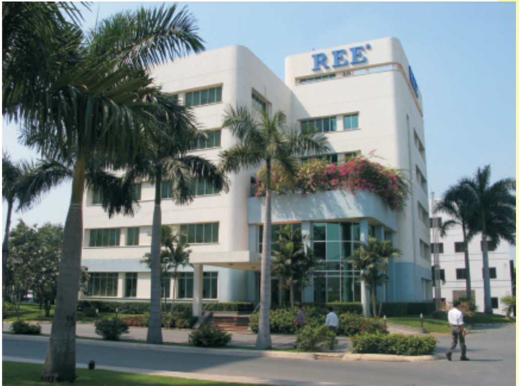
Trụ sở Công ty Cổ phần Cơ Điện Lạnh R.E.E
