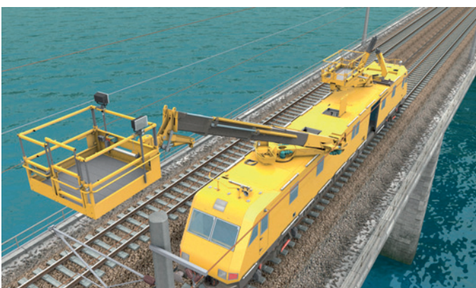
Abb. 3: Bühnen und Drückanlage in Arbeitsstellung
