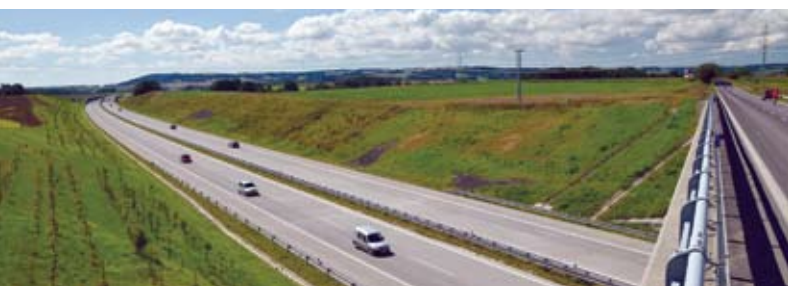
Most na silnici Pustějov–Kujavy
