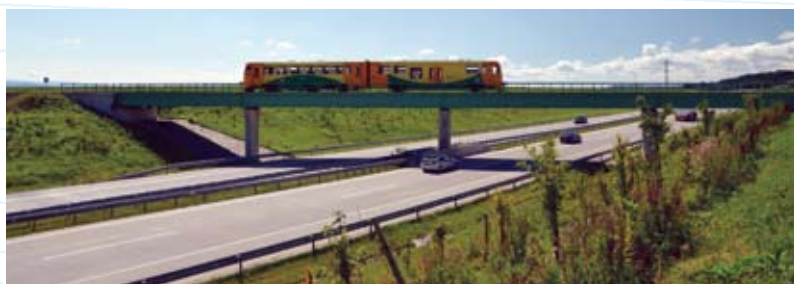
Most na železniční trati Studénka–Bílovec
