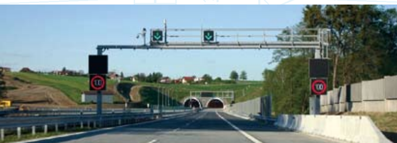
Příjezd k tunelu Klimkovic od Brna
