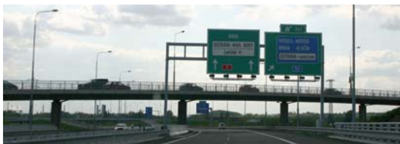
Návěst před výjezdem 361, směr Brno
