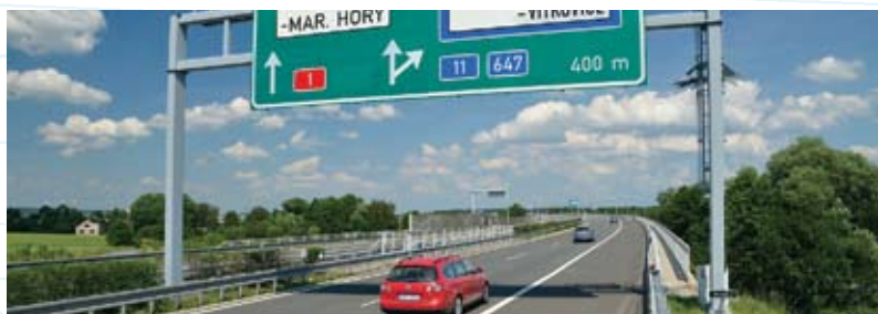
Estakáda přes Polaneckou ulici, rybník Rojek a železniční trať
