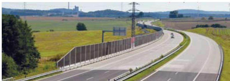
D1 před Běloutínem, pohled směr Brno
