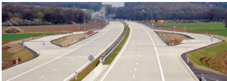
Pomocný silniční pozemek před státní hranicí
