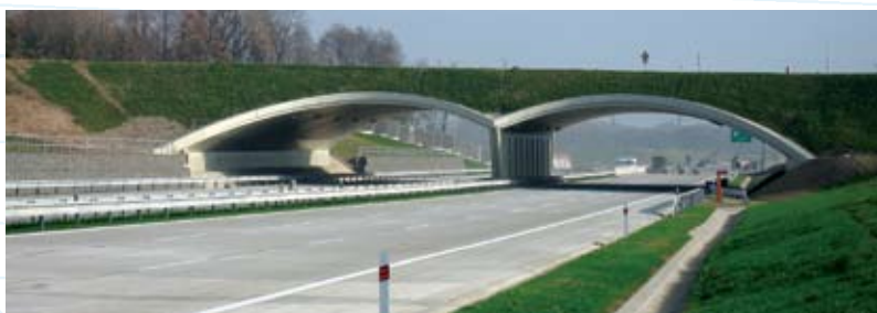
Přesypaný most u obce Hrabůvka
