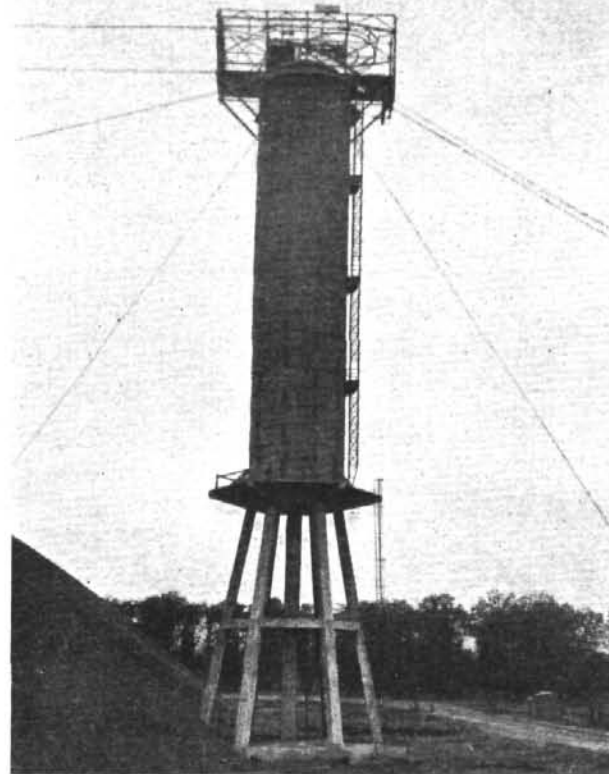
Abb. 1. Zeche Mathias Stinnes Karnap, Wasserbehälter mit Cowperturm.
