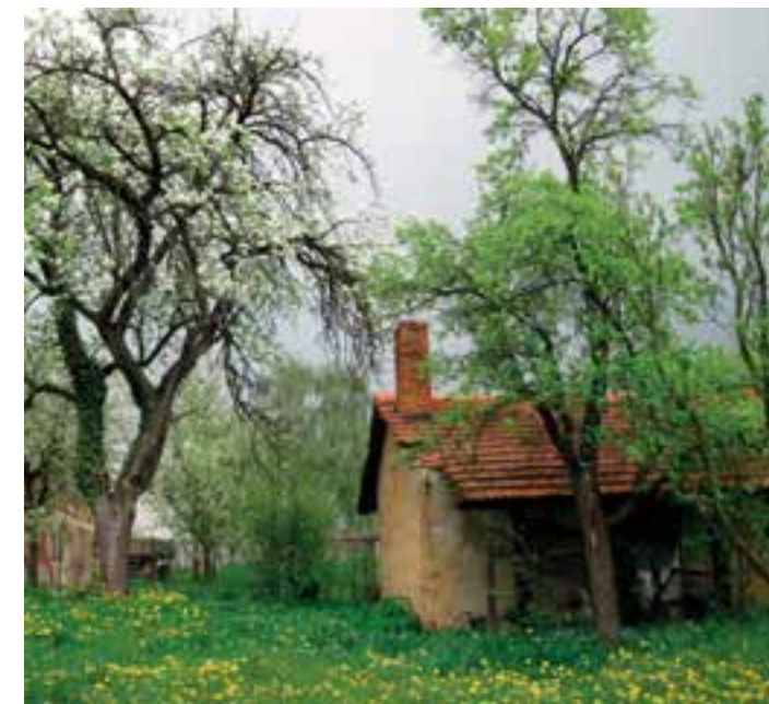
Bývalá sušárna v Bernarticích. (foto Ivan Bartoš)
