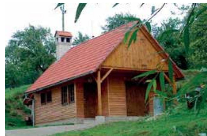
Nově zbudovaná obecní sušárna v Rudimově. (foto archiv obce Rudimov)
