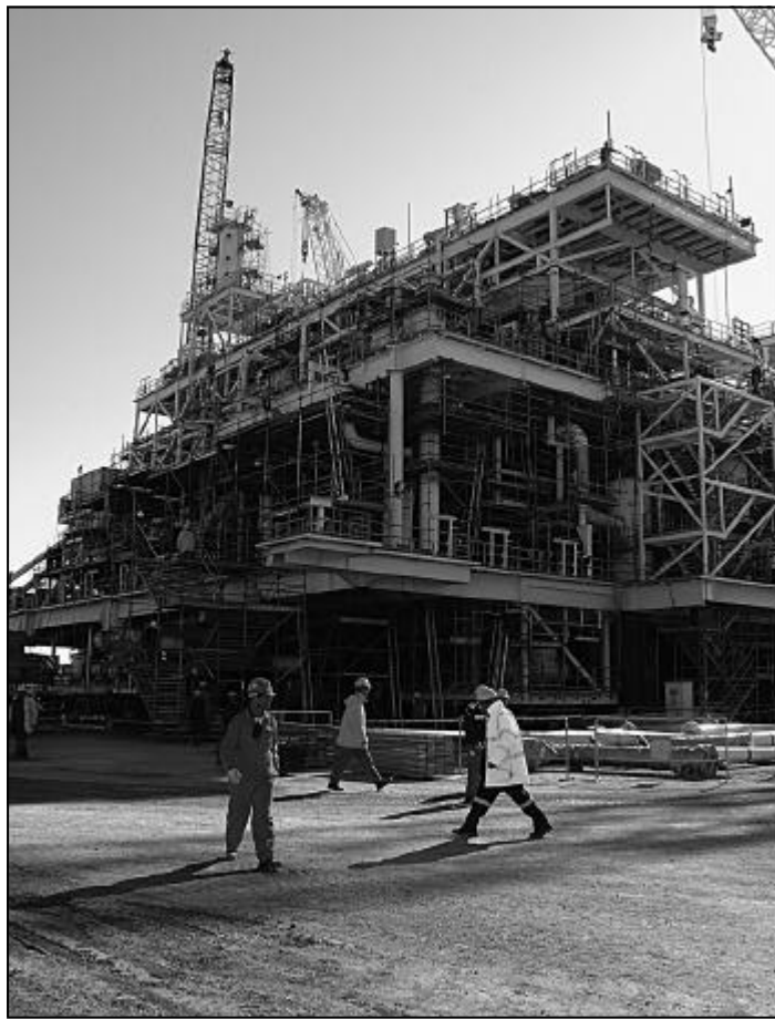
Строительство водонагнетательной платформы близится к завершению
