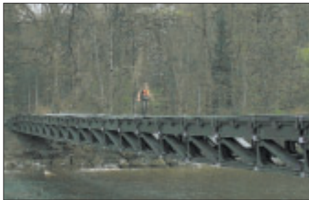
Feste Brücke 69 im Einsatz.
