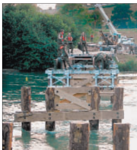
G-Truppen im Einsatz: Eine Brücke entsteht.
