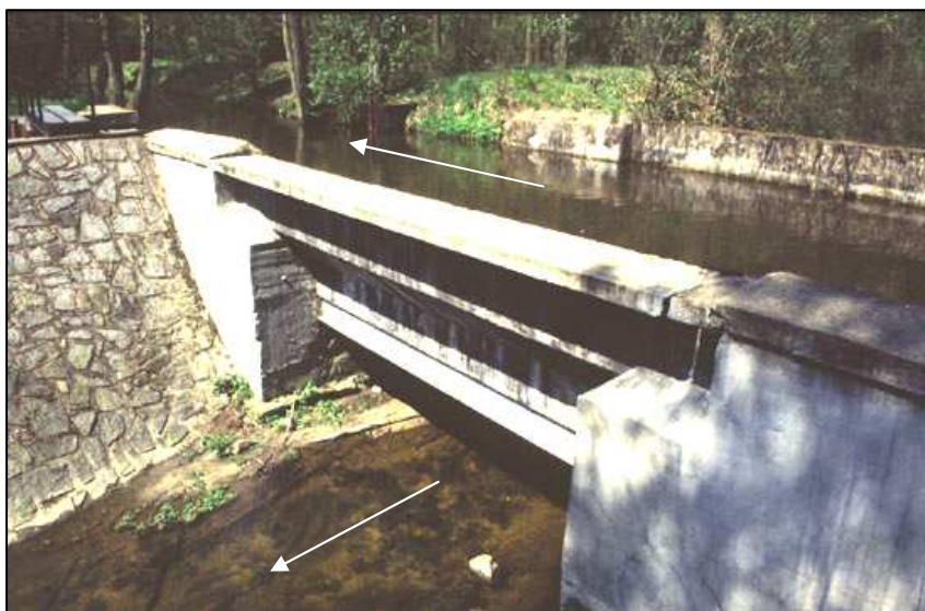
Kanál s podtékajícím odpadem – Muldou.
