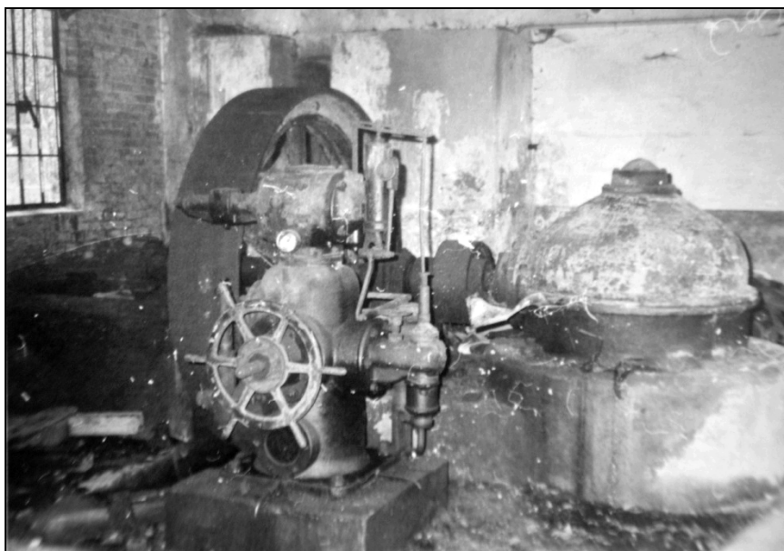
Chátrající zařízení elektrárny, která po kolektivizaci neměla majitele. Foto 1957.
