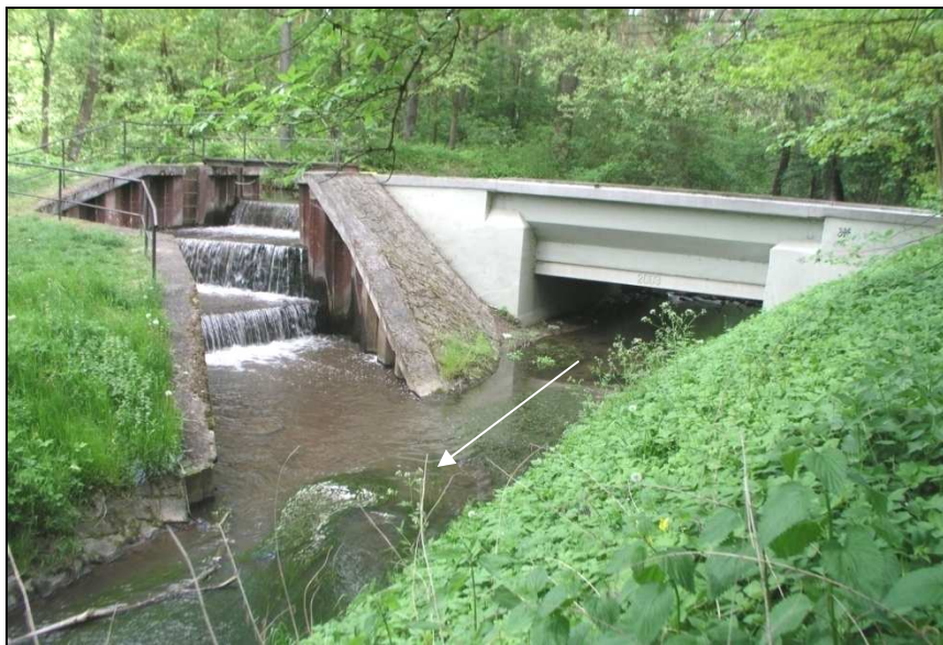
Odlehčovací stavidlo na semínském akvaduktu.
