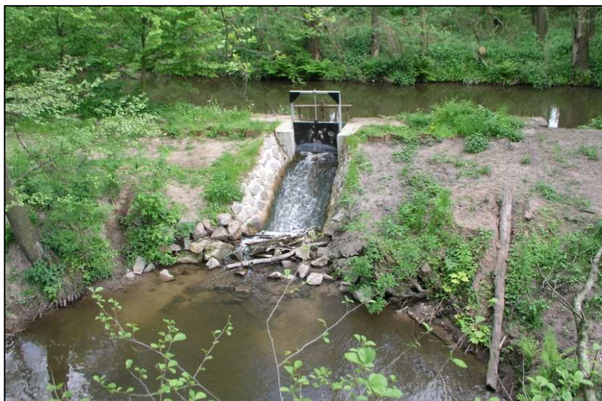
Pohled na nově vybudovanou výpust. Foto J.Půlpán, květen 2008.
