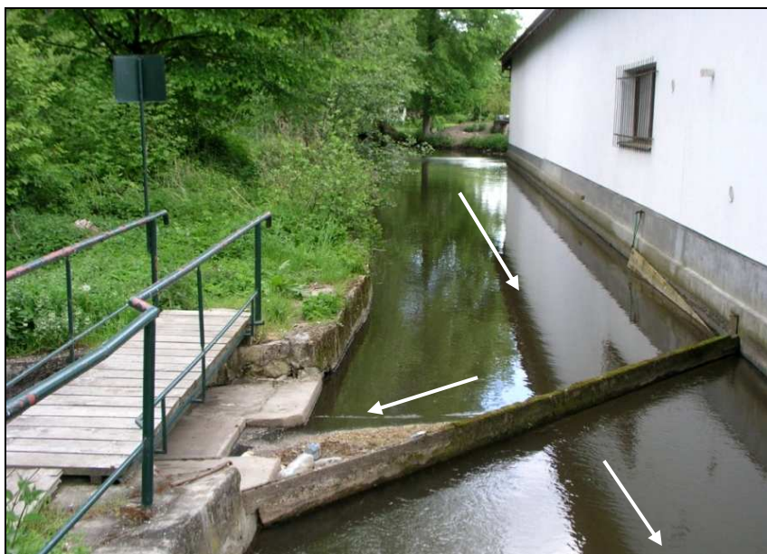
Přítok kanálu k Výrovskému mlýnu s normou stěnou a vlevo s přepadem.
