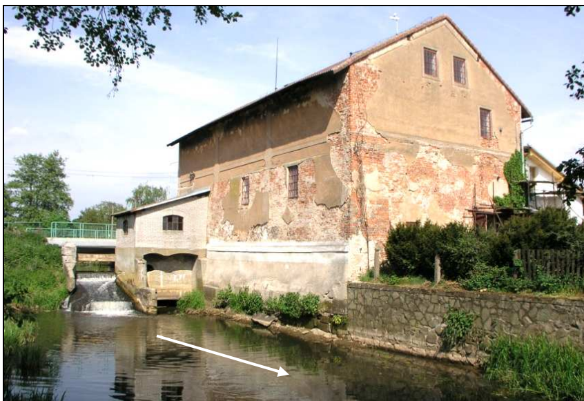
Pohled na mlýn proti vodě.
