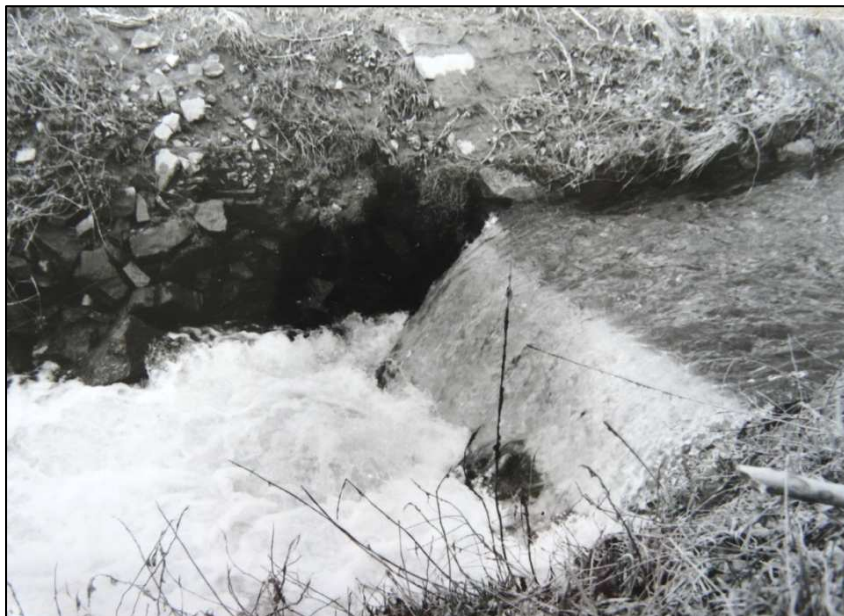
Detail vtoku kanálu do Labe pod Semínem v km 32,690.. Zde má kanál průměrný průtok asi 0,12 m 3 , s -1 . Foto J.Chudý 2003.
