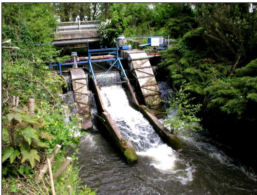
Malá vodní elektrárna na kanálu ve Starých Žďánicích. Foto J.Půlpán.
