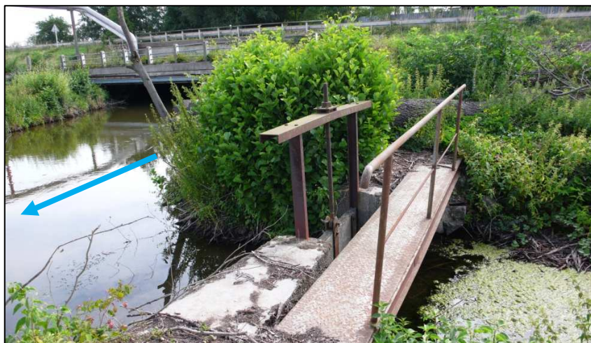
Detail výpustného stavidla z kanálu pro bývalý rybník „Šeperka“. V pozadí původní most přes kanál sinice č. 37 z roku 1819.
