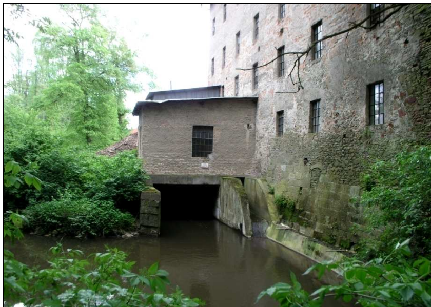
Výtok kanálu z výrovského mlýnu v km 25,685.
