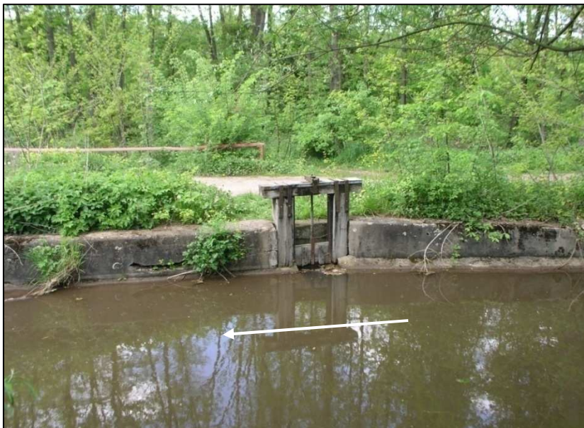
Stavidlo v Semíně pro výtok z kanálu do Kladubského hřebčína.
