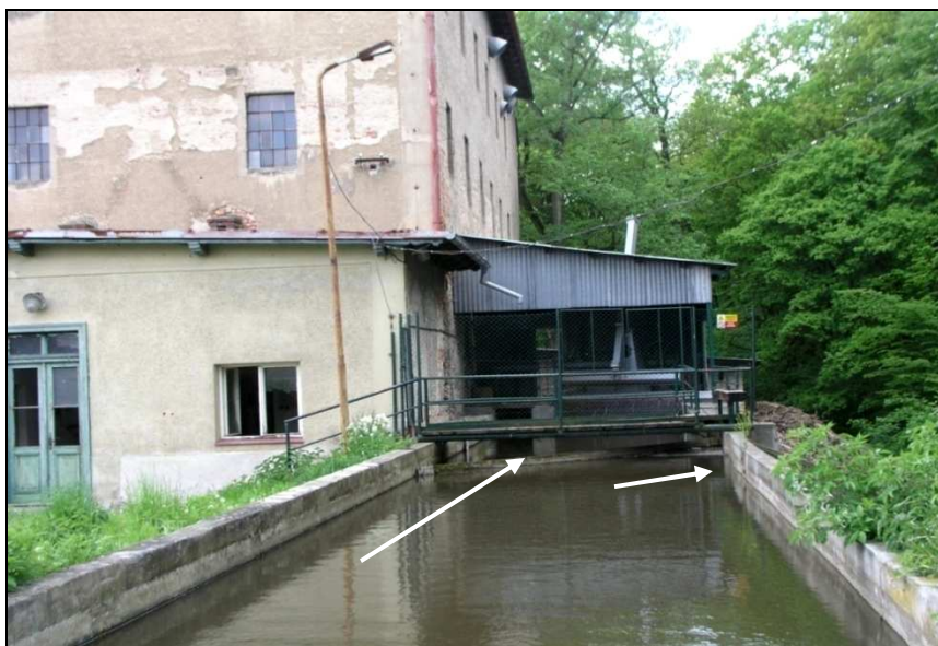
Vtok do mlýnu na turbíny, vpravo jalové stavidlo s přepadem.
