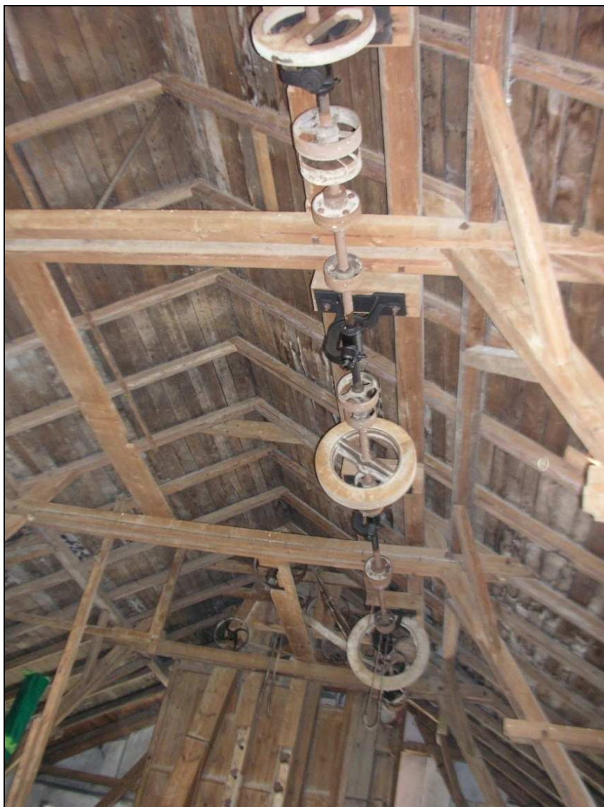
Transmise s kovovými a dřevěnými řemenicemi umístěnými v nejvyšším patře mlýna.
