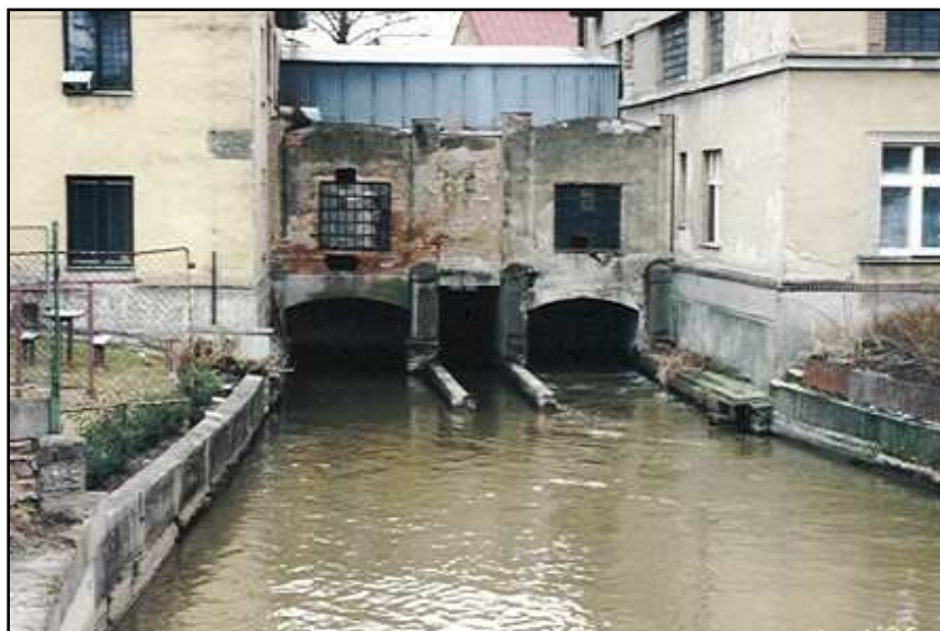
Detail výtoku z Bohdanečských mlýnů, uprostřed jalové stavidlo. Foto Chudý 2003.
