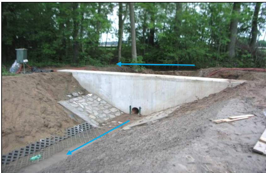
Nově budovaný výtok a renovace bývalé „Velké strúhy“
