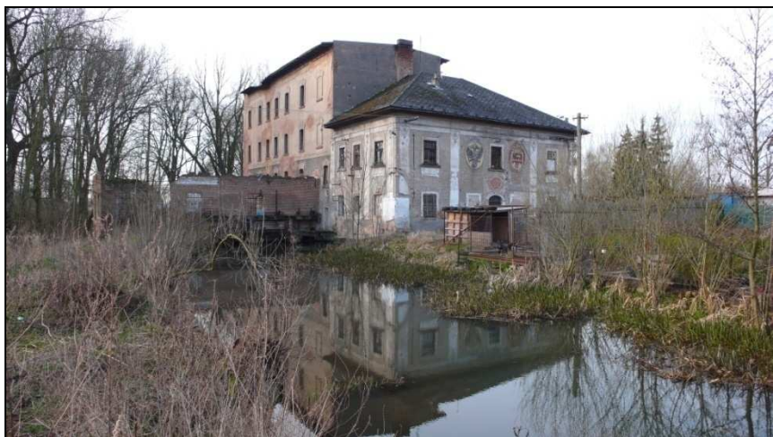
Současný zchátralý Morávkův mlýn čp. 48. Foto Chudý 2008.
