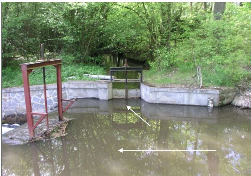
Detail jezu s odbočným stavidlem. Foto Půlpán 2008.
