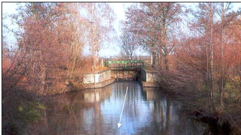
Ždánická stavidla na kanálu. Foto J.Chudý, 2008.
