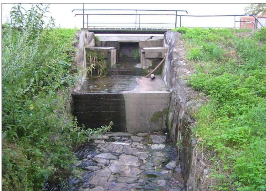
Přepadový kanál je ochranou mlýna před velkou vodou.
