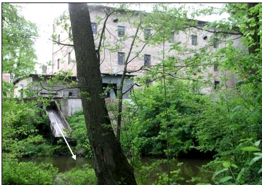
Dřevěný žlab od jalového stavidla, spodní koryto obtéká mlýn. Obrázky na str.89-92 zhotovil Josef Půlpán.
