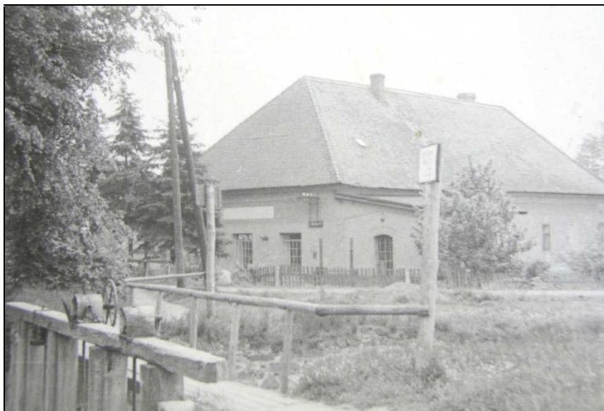
Morávkův mlýn-elektřárna čp. 43. Vlevo dole Ždánická stavidla. Foto asi rok 1950.
