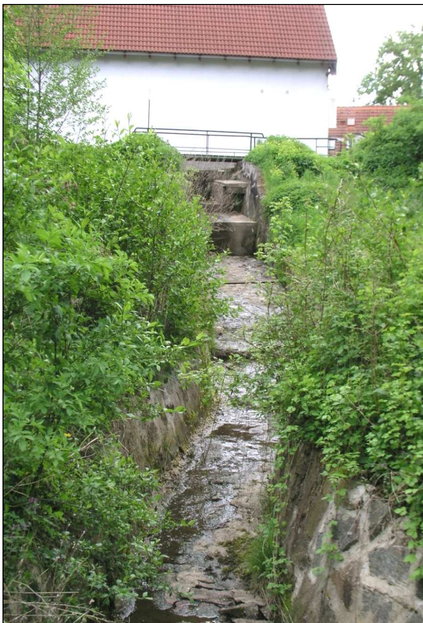
Přepadový kanál má značný spád a výškový rozdíl hladin zde činí cca 6 m.
