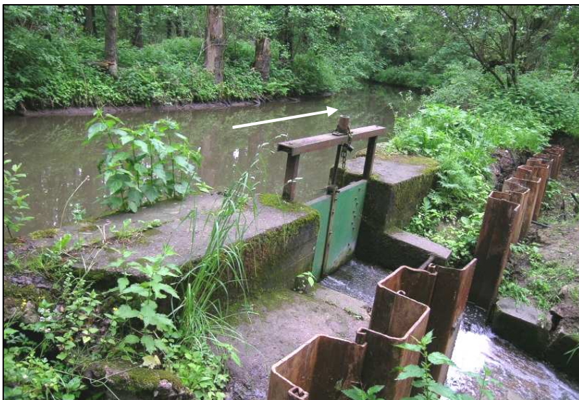
Pohled na zabezpečenou hráz se stavidlem v roce 2007.
