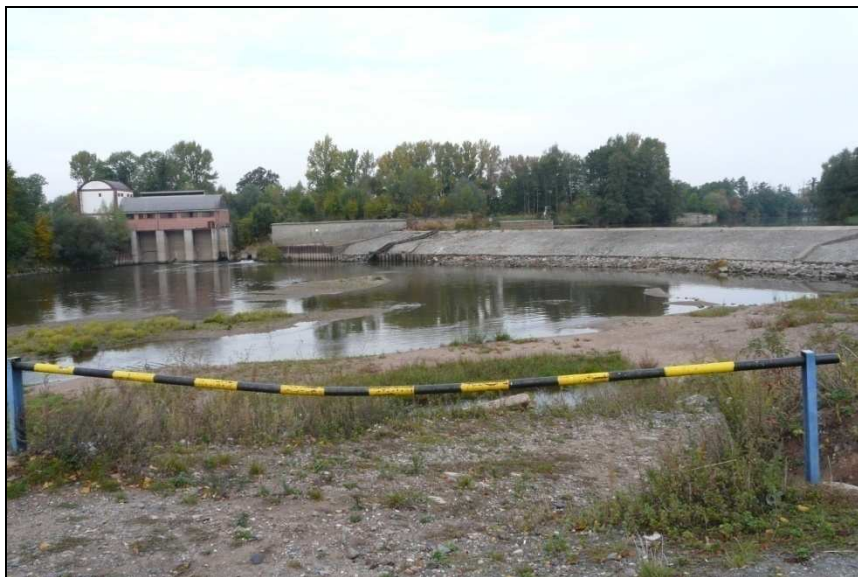
Současný Opatovický jez, po většinu roku suchý, protože vodu odebírá přivaděč do EOP a dále malá vodní elektrárna na obr. vlevo. Foto J.Chudý.
