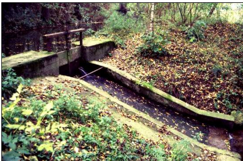
Stavidlo v pravém břehu kanálu pro napouštění bohदानeckých rybníků. 19
