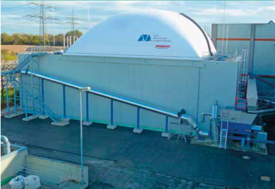
Thöni Trockenvergärungsanlage (TTV) der AVA Augsburg
