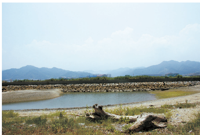
写真7 初期船着場の現状
