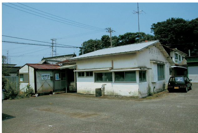
写真14 営業所建物の現状（平成18年8月4日撮影） 多喜浜の塩田で作られた塩を扱うための専売局の跡地に建てられ、現在は、多喜浜漁協が使用している。建物の奥側は航空営業所時代はなく、増設されている。
