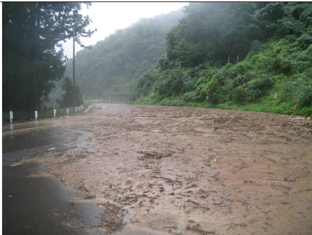
豪雨時土砂流出した道路
