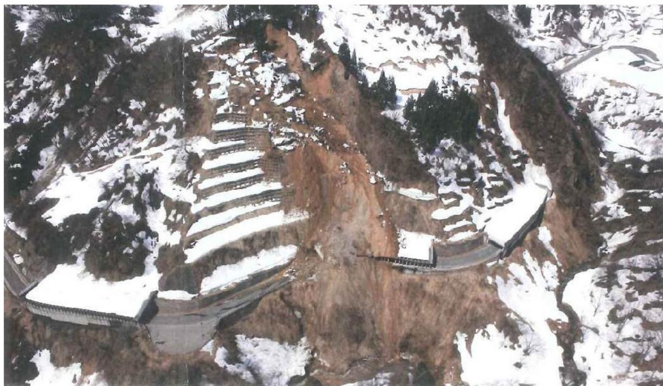
一般国道353号 十二峠 猿倉スノーシェッド上空写真 (十日町市笹沢)
