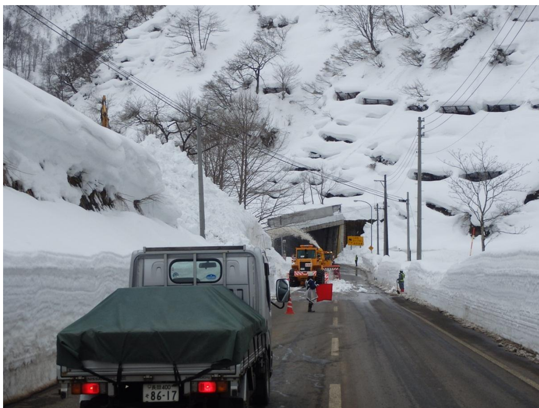
片側交互通行による雪庇処理状況
