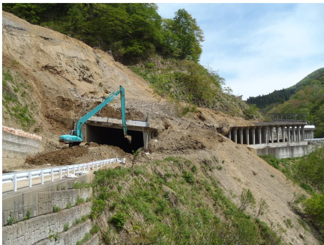
バックホーによる土砂撤去作業（平成26年5月12日撮影）
