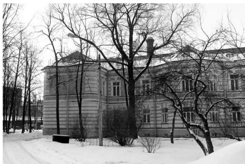
Корпус им. Э.Э. Эйхвальда после капитального ремонта. В нем разместился Нефрологический центр
